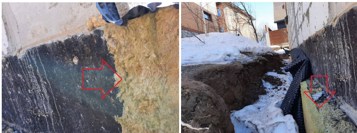
Фото №№ 3, 4 Материал, предназначенный для утепления полов внутри здания.
