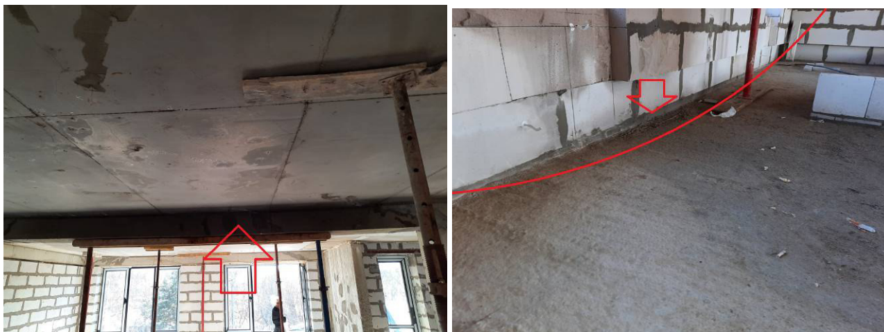
Фото №№ 36, 37 Прогиб плиты перекрытия.
