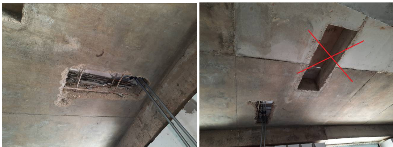
Фото №№ 30, 31 Нарушение проекта при устройстве проёма.
