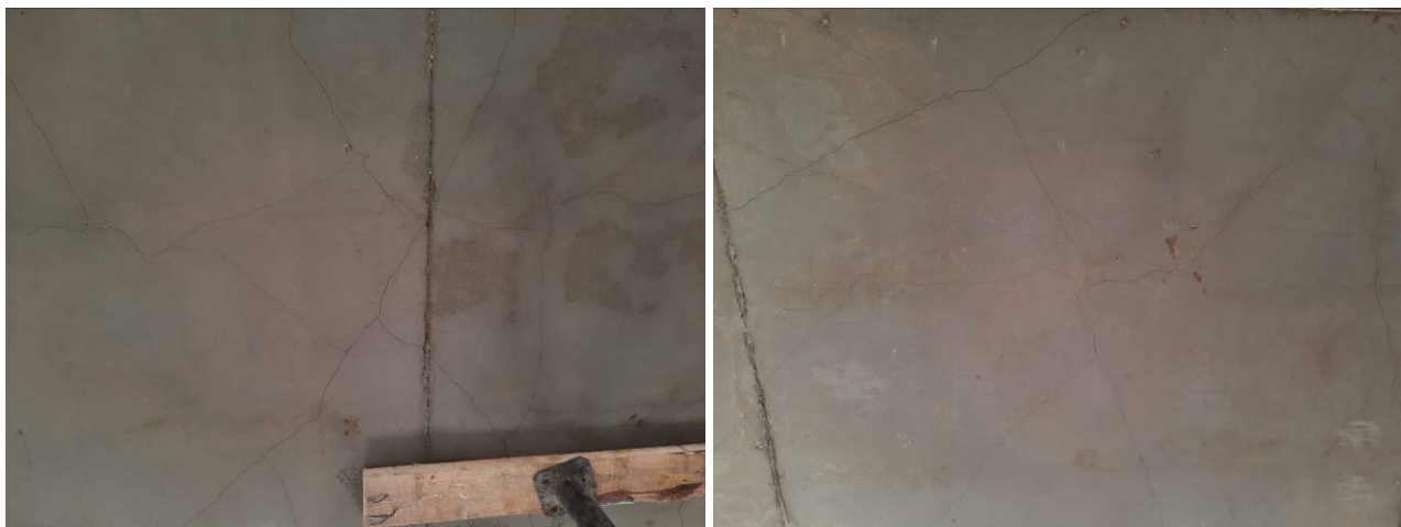
Фото №№ 41, 42 Растрескивания плиты перекрытия на отметке +5900.
