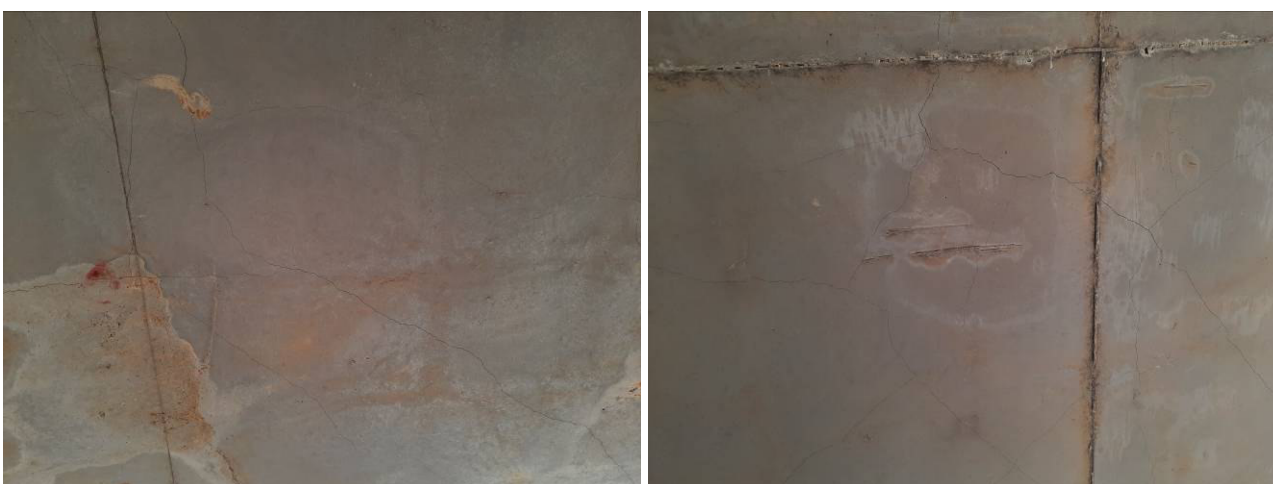
Фото №№ 45, 46 Растрескивания плиты перекрытия на отметке +5900.
