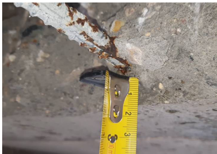
Фото № 91 Защитный слой армирования 15 мм.
