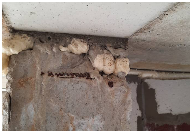
Фото №№ 23, 24 Обнажение арматуры. Следы неуплотнённого бетона.
