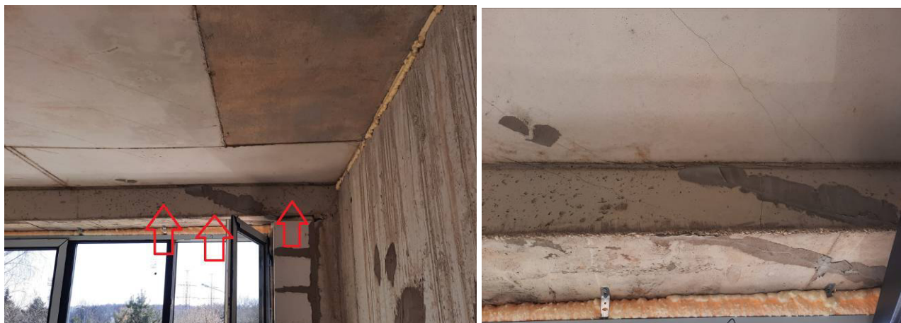
Фото №№ 58, 59 Растрескивания балок перекрытия на отметке +5900.
