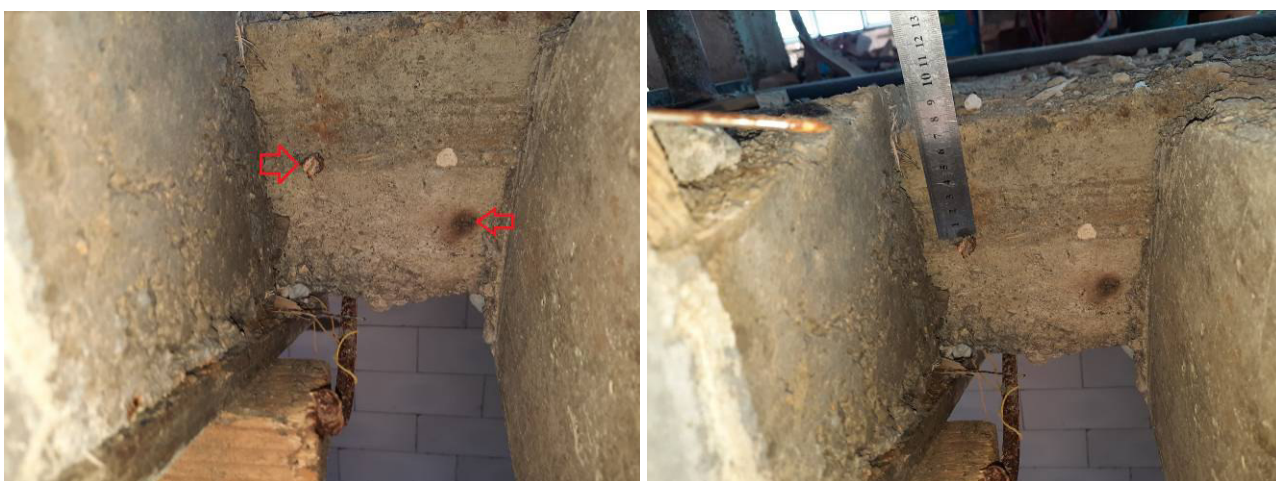
Фото №№ 87, 88 Неравномерное распределение армирования в плите. Защитный слой 7 см.
