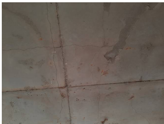
Фото №№ 39, 40 Растрескивания плиты перекрытия на отметке +5900.
