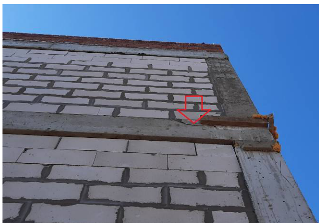
Фото №№ 73, 74 Растрескивания монолитных конструкций.
