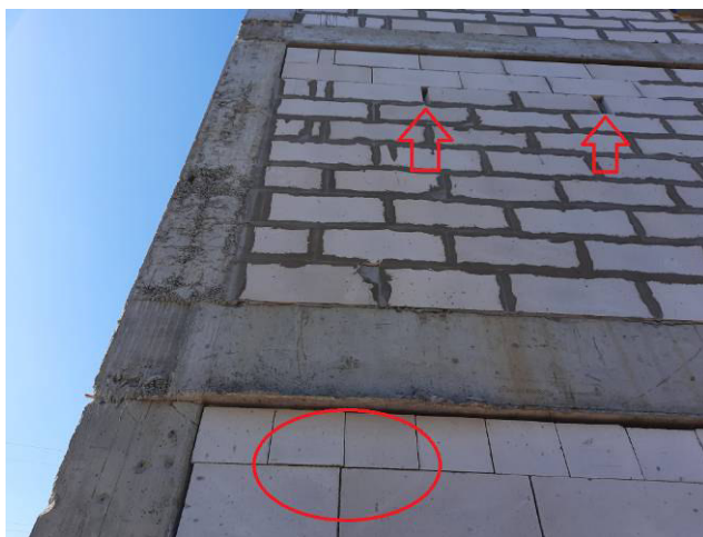
Фото № 12 Отсутствует перевязка кладки. Повреждённые блоки.
