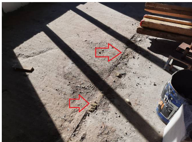
Фото №№ 15, 16 Обнажение арматуры, отсутствует защитный слой.
