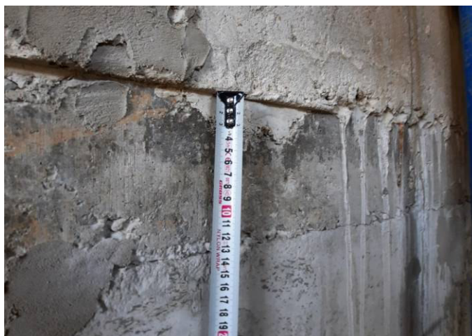
Фото № 100 Толщина плиты перекрытия 13 см.
