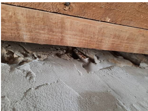
Фото №№ 23, 24 Обнажение арматуры. Следы неуплотнённого бетона.
