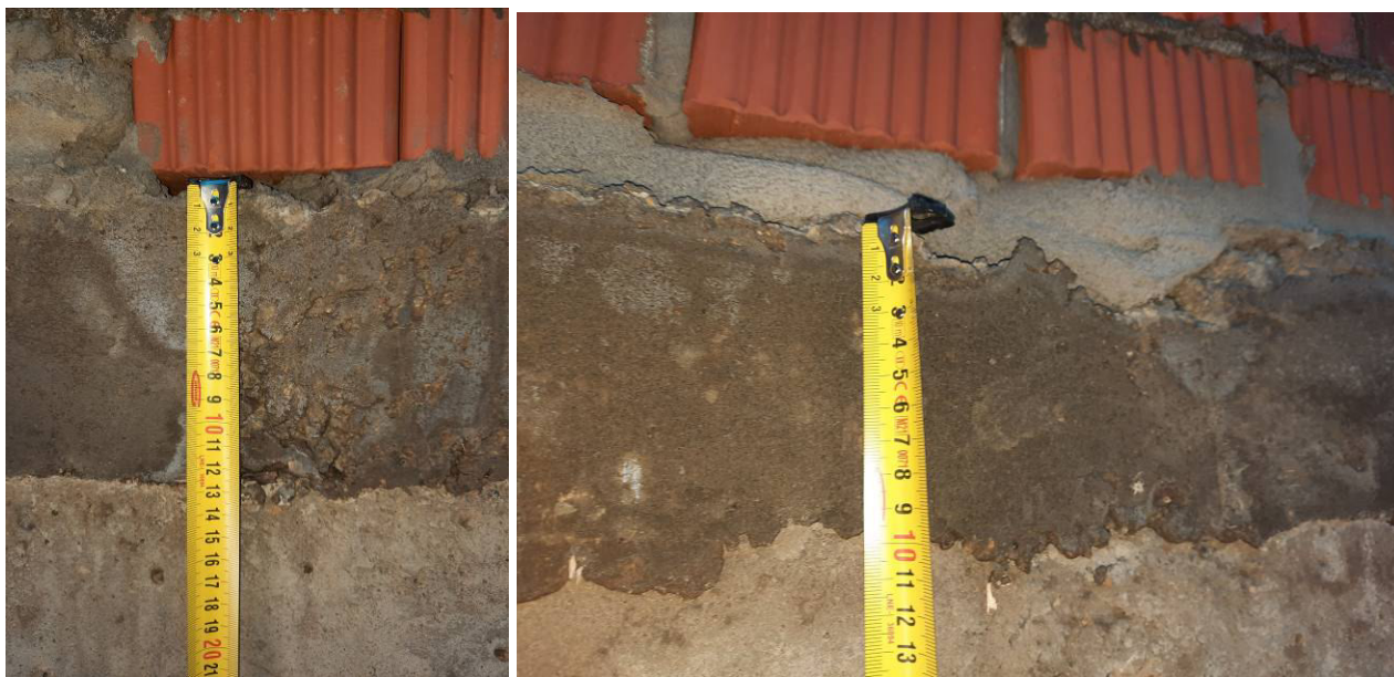
Фото №№ 92, 93 Толщина плиты перекрытия 12 и 10 см.
