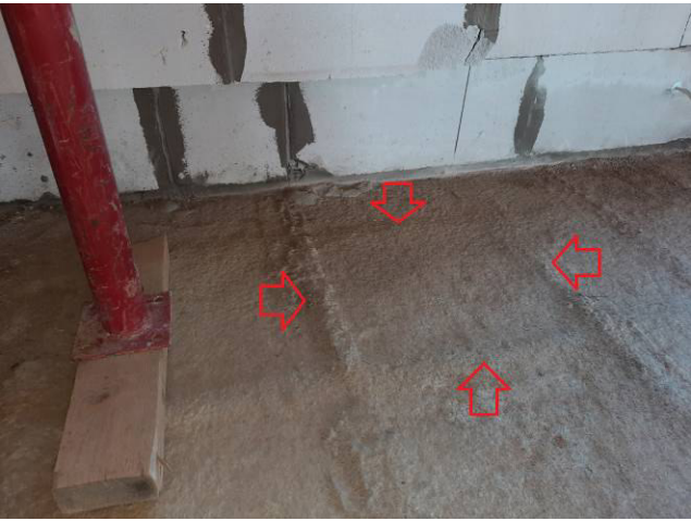
Фото №№ 81, 82 Шаг армирования плиты перекрытия до 40 см.
