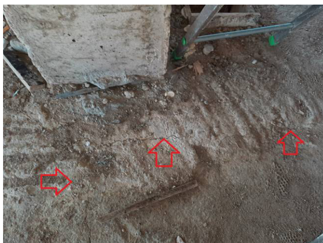
Фото №№ 51, 52 Растрескивания плиты перекрытия на отметке +5900.
