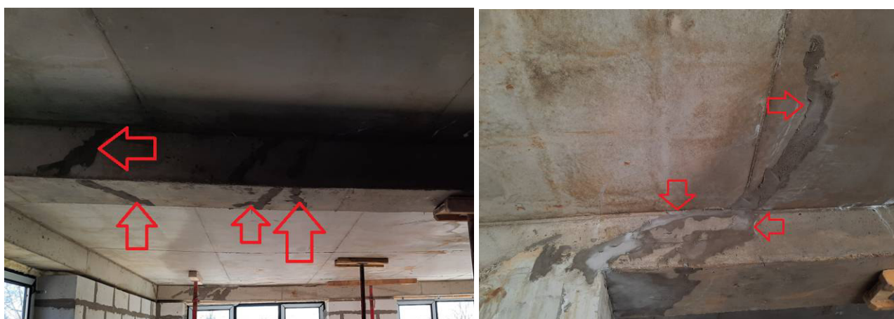
Фото №№ 56, 57 Растрескивания балок перекрытия на отметке +5900.
