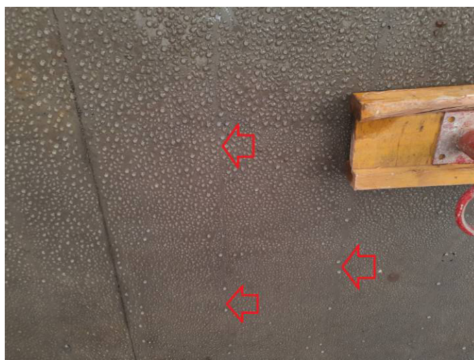
Фото № 55 Растрескивания плиты перекрытия на отметке +8900.
