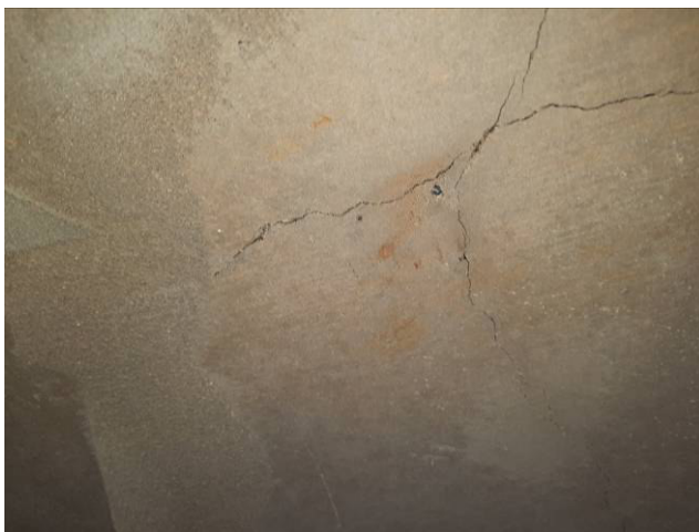
Фото №№ 47, 48 Растрескивания плиты перекрытия на отметке +5900.
