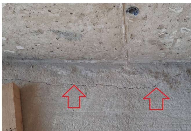
Фото №№ 49, 50 Растрескивания плиты перекрытия на отметке +5900.
