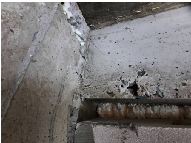
Фото №№ 17, 18 Обнажение арматуры, отсутствует защитный слой.
