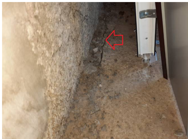
Фото №№ 51, 52 Растрескивания плиты перекрытия на отметке +5900.
