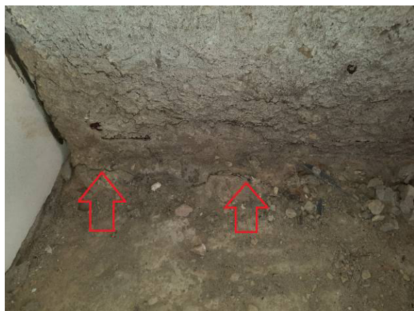
Фото №№ 49, 50 Растрескивания плиты перекрытия на отметке +5900.
