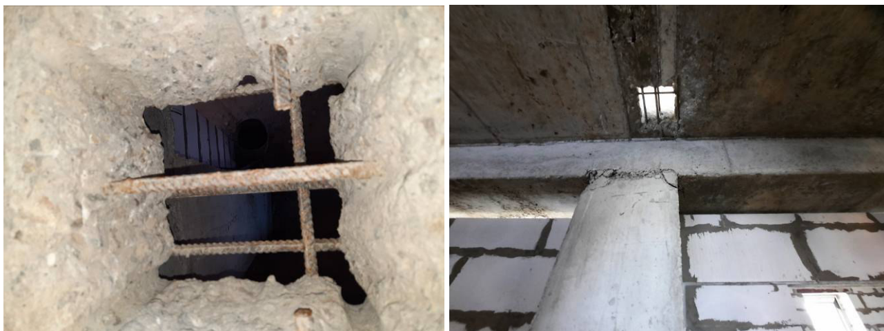
Фото №№ 32, 33 Нарушение армирования при устройстве отверстий в перекрытиях.
