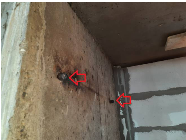
Фото №№ 19, 20 Обнажение арматуры, отсутствует защитный слой.
