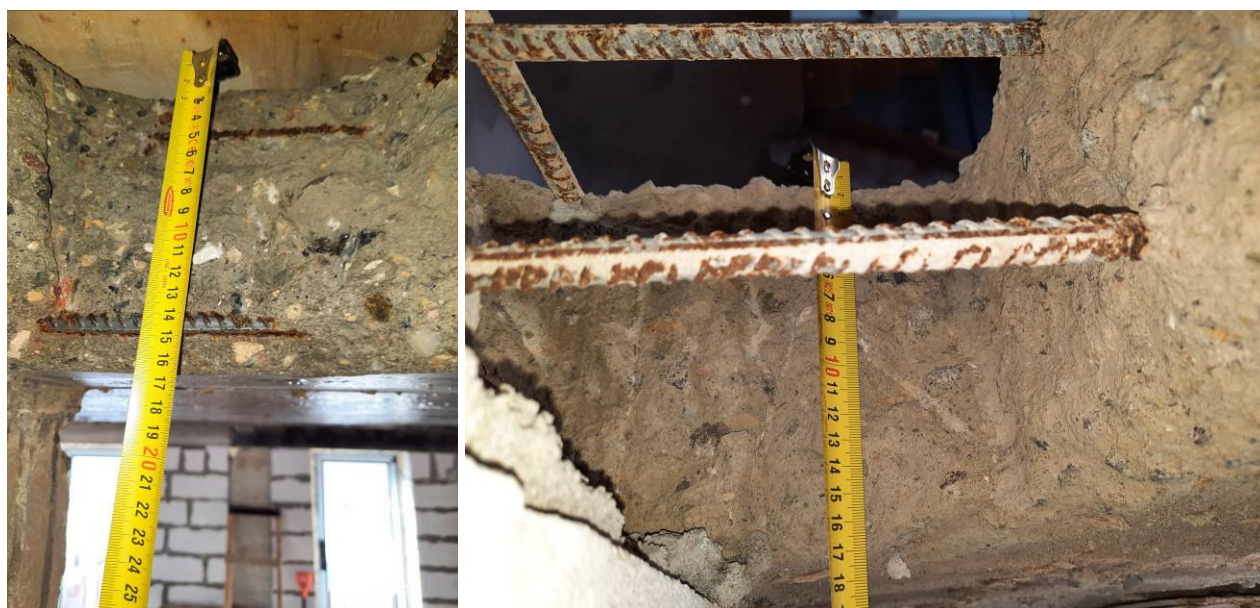
Фото №№ 94, 95 Толщина плиты перекрытия 16,5 и 17 см.
