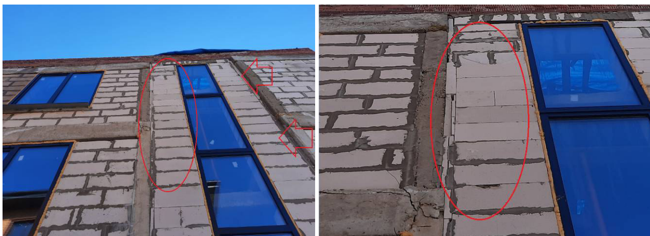
Фото №№ 10, 11 Нарушение технологии кладки. Отсутствует перевязка.
