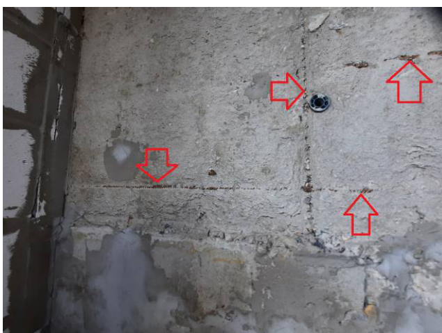
Фото №№ 21, 22 Обнажение арматуры, отсутствует защитный слой. Следы неуплотнённого бетона.
