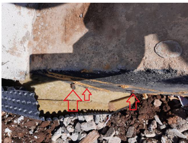
Фото №№ 13, 14 Следы неуплотнённого бетона. Обнажение арматуры, отсутствует защитный слой.
