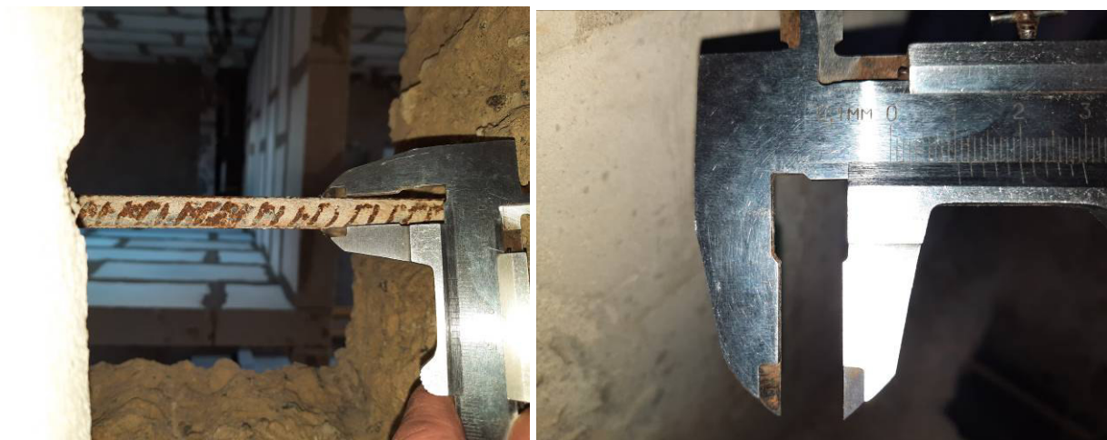
Фото №№ 76, 77 Толщина арматуры 10 мм.
