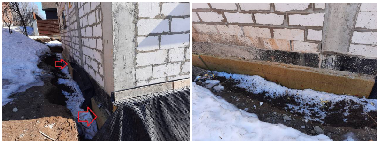
Фото №№ 5, 6 Материал, предназначенный для утепления полов внутри здания.
