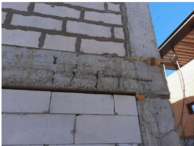
Фото №№ 13, 14 Следы неуплотнённого бетона. Обнажение арматуры, отсутствует защитный слой.
