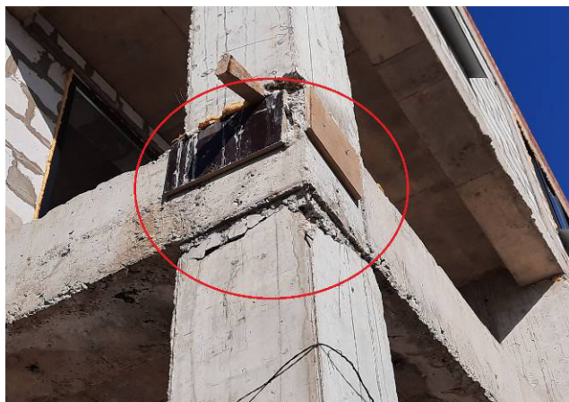
Фото №№ 73, 74 Растрескивания монолитных конструкций.
