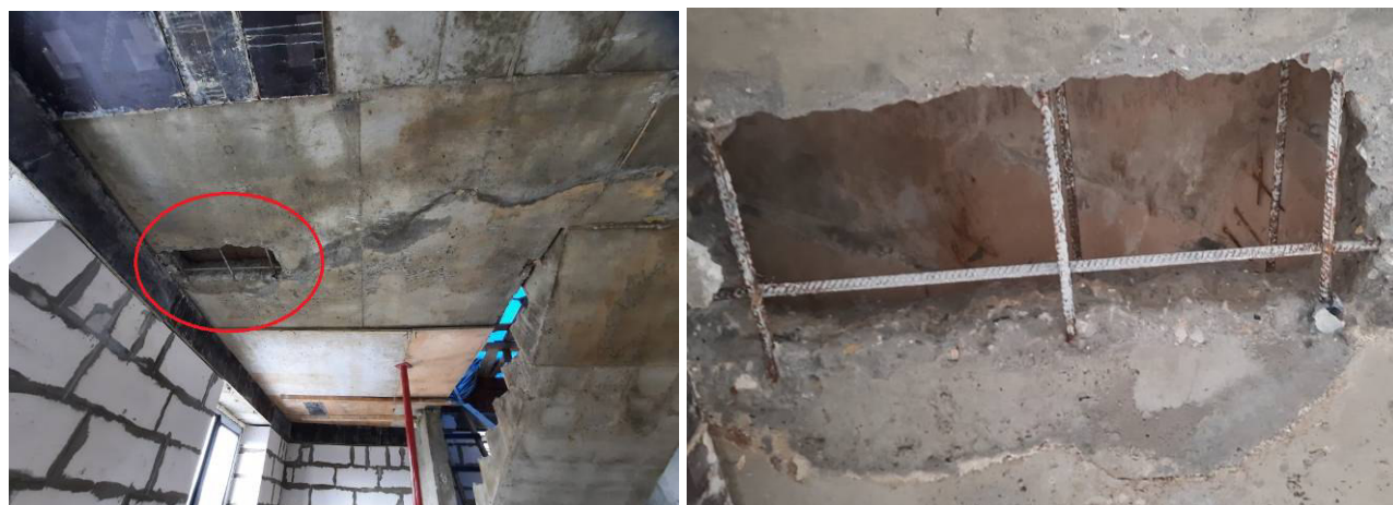
Фото №№ 34, 35 Нарушение армирования при устройстве отверстий в перекрытиях.
