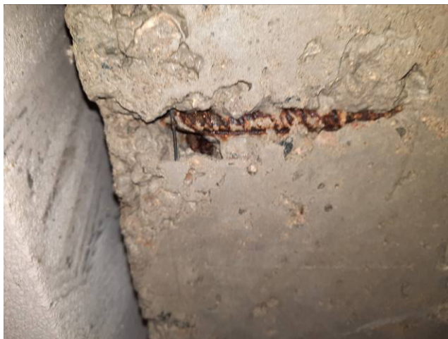
Фото №№ 15, 16 Обнажение арматуры, отсутствует защитный слой.
