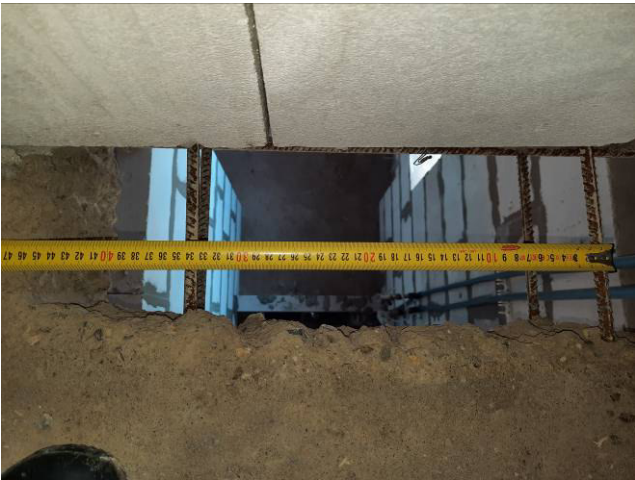
Фото №№ 79, 80 Шаг армирования плиты перекрытия 34 и 27 см.
