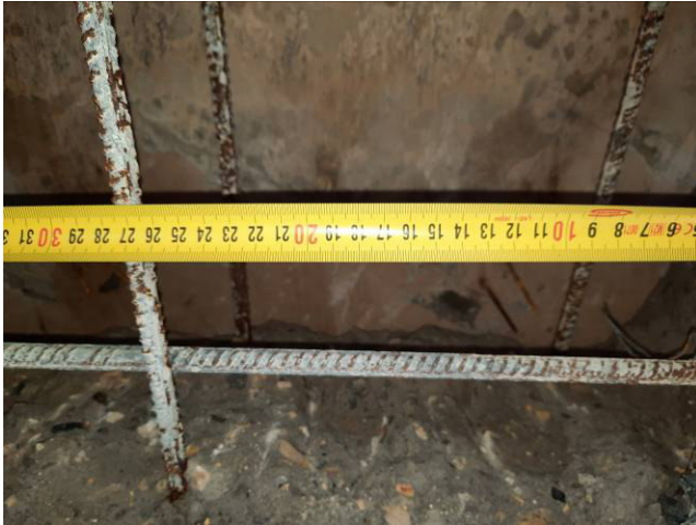
Фото №№ 79, 80 Шаг армирования плиты перекрытия 34 и 27 см.
