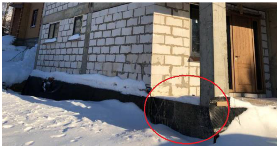
Фото № 105 Отсутствует устройство лестничного марша.
