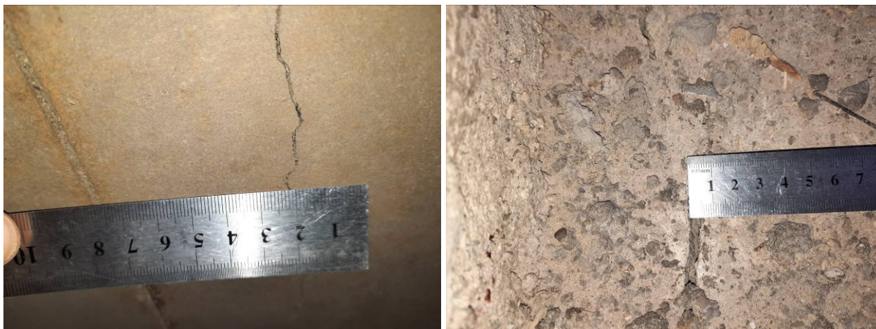
Фото №№ 69, 70 Раскрытие трещин в плите перекрытия до 5 мм.
