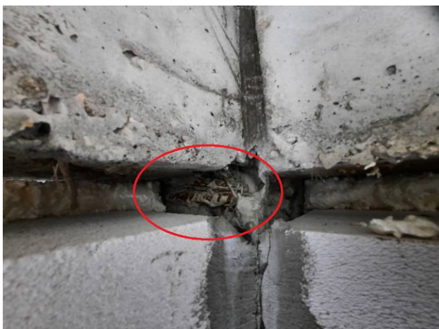
Фото №№ 17, 18 Обнажение арматуры, отсутствует защитный слой.
