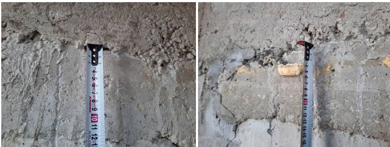
Фото №№ 96, 97 Толщина плиты перекрытия 12 и 14 см.
