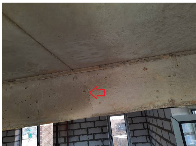
Фото № 68 Растрескивание балки на отметке +5900.
