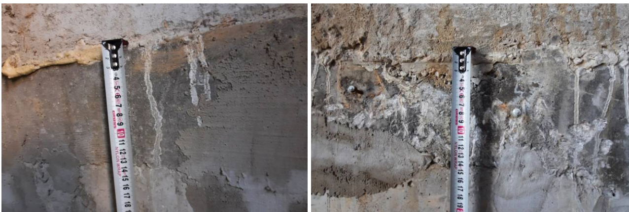
Фото №№ 98, 99 Толщина плиты перекрытия 14 см.
