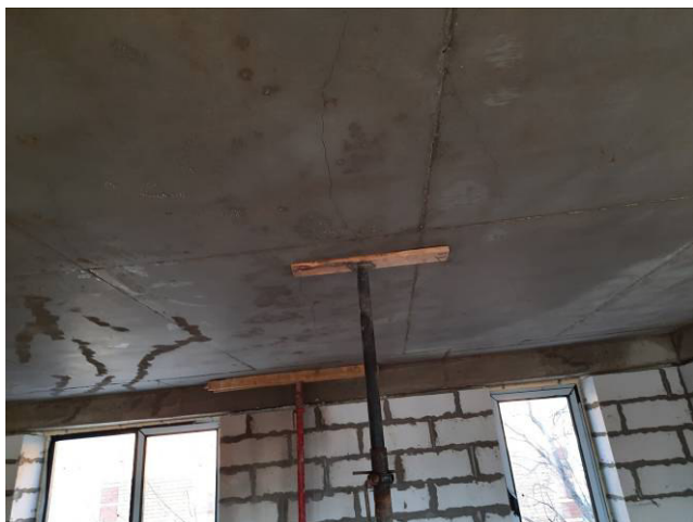
Фото №№ 47, 48 Растрескивания плиты перекрытия на отметке +5900.
