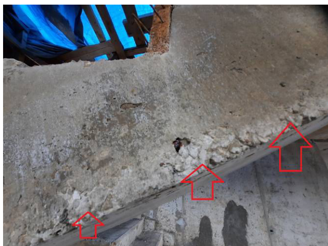
Фото №№ 21, 22 Обнажение арматуры, отсутствует защитный слой. Следы неуплотнённого бетона.
