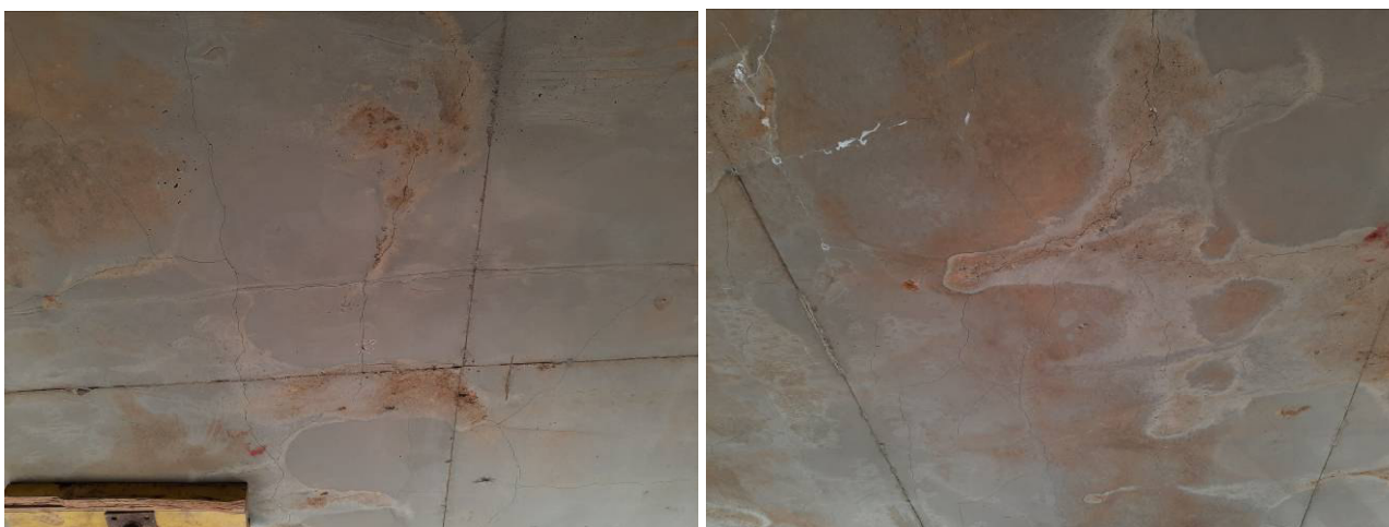
Фото №№ 43, 44 Растрескивания плиты перекрытия на отметке +5900.
