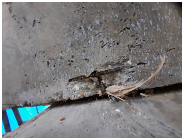
Фото №№ 19, 20 Обнажение арматуры, отсутствует защитный слой.
