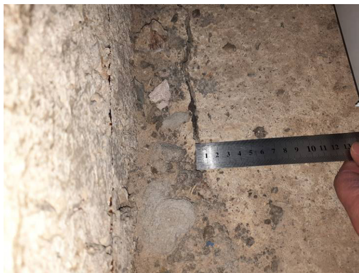
Фото № 71 Раскрытие трещин в плите перекрытия 5 мм.
