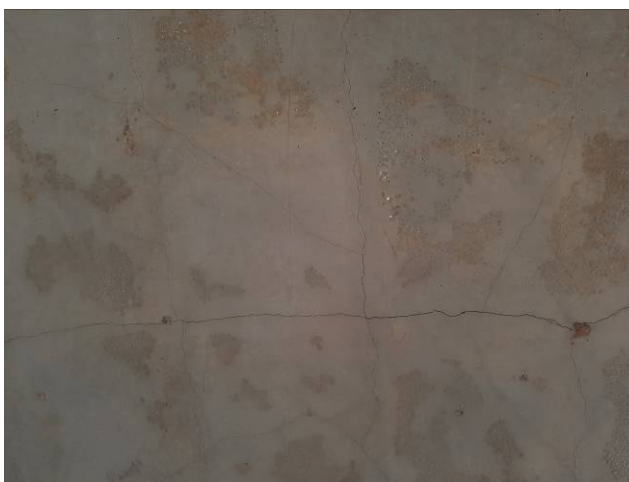
Фото №№ 39, 40 Растрескивания плиты перекрытия на отметке +5900.
