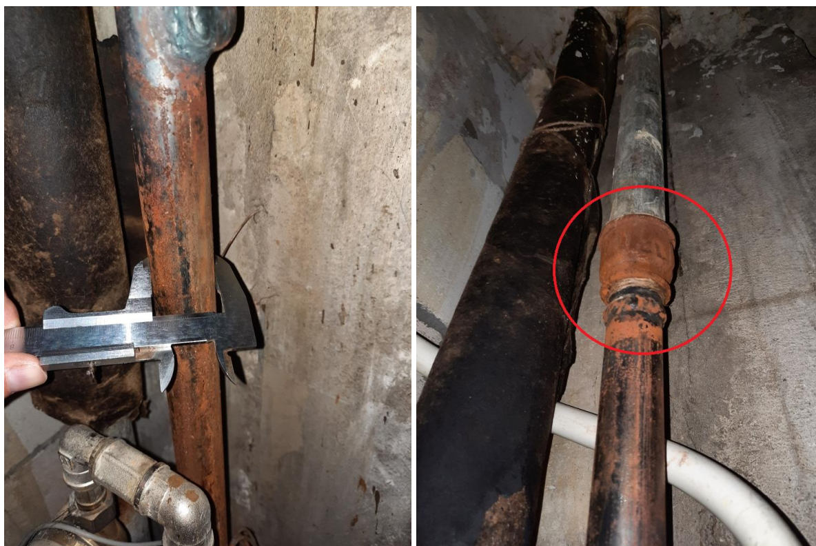
Фото №№ 5, 6 Следы коррозии на стояке ГВС. Место перехода диаметра стояка
