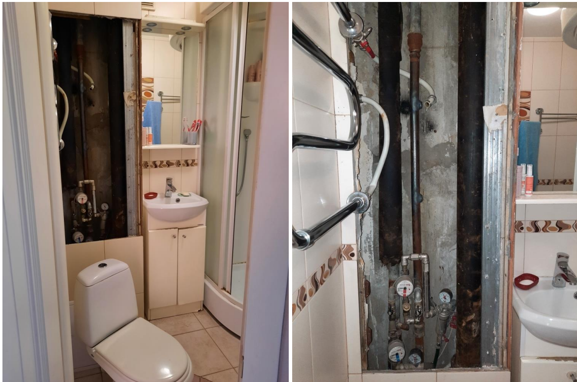
Фото №№ 1, 2 Общий вид санузла. Сантехнический шкаф с общедомовыми стояками
