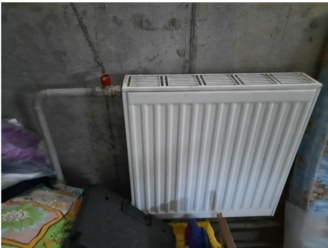
Фото 14. Элементы системы отопления (отопительные приборы) в помещении, обслуживающие непосредственно данное помещение
