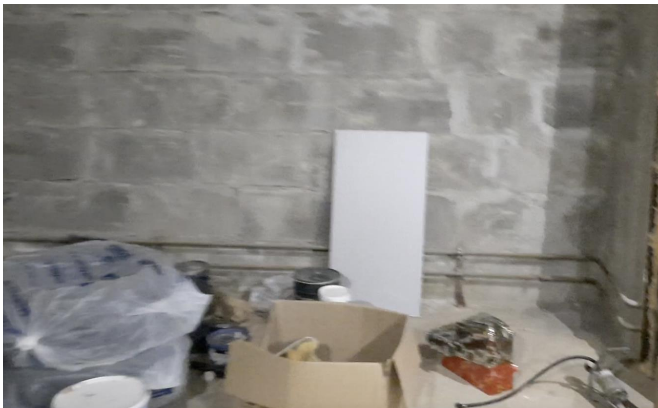
Фото 17. Элементы системы отопления (подводка к отопительным приборам) в помещении, обслуживающие непосредственно данное помещение
