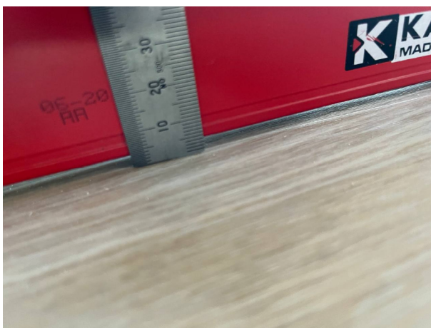
Фото №№ 90, 91 Отклонения от плоскости 4 и 3 мм.
