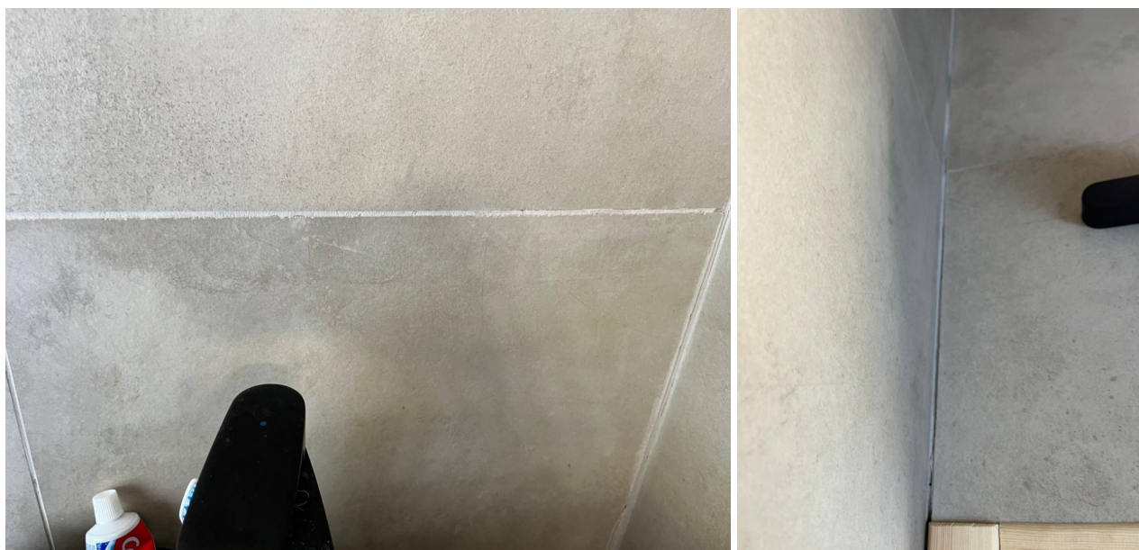
Фото №№ 108, 109 Скол на плитке. Растрескивание затирочной смеси.
