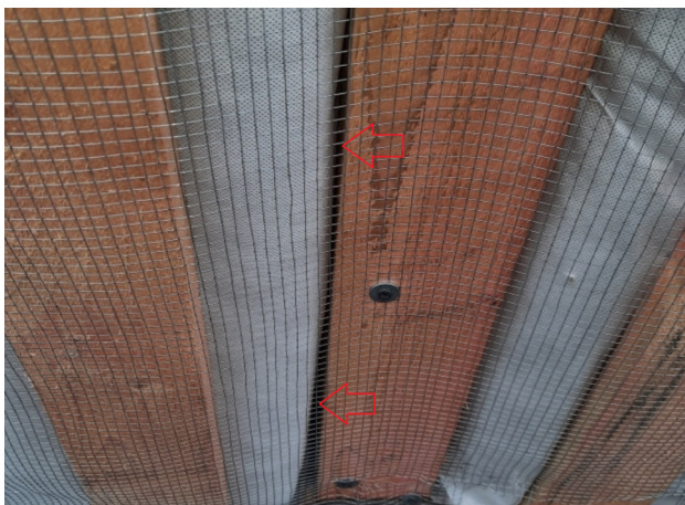
Фото №№ 17, 18 Утеплитель уложен неплотно.
