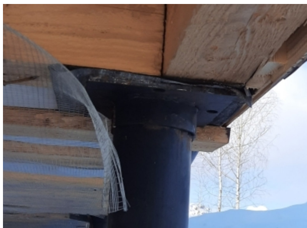
Фото №№ 41, 42 Оголовки не закреплены к обвязке дома.
