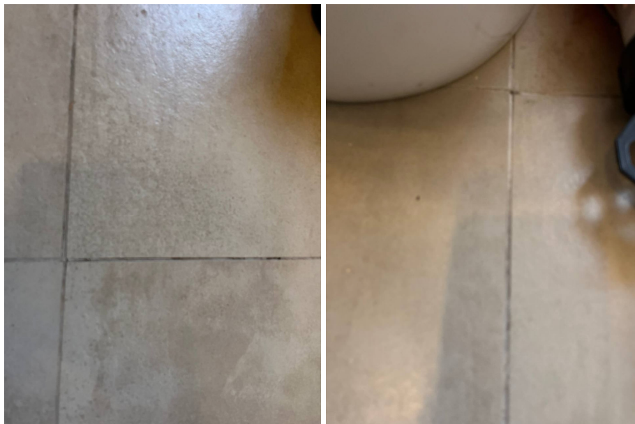
Фото №№ 112, 113 Растрескивания затирочной смеси по швам. Зыбкое основание.
