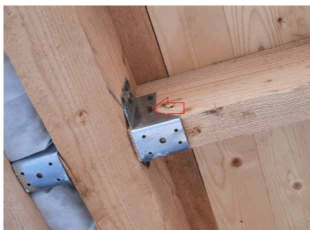
Фото №№ 9, 10 Крепление «черными» саморезами. Отсутствует гидроизоляционный слой.
