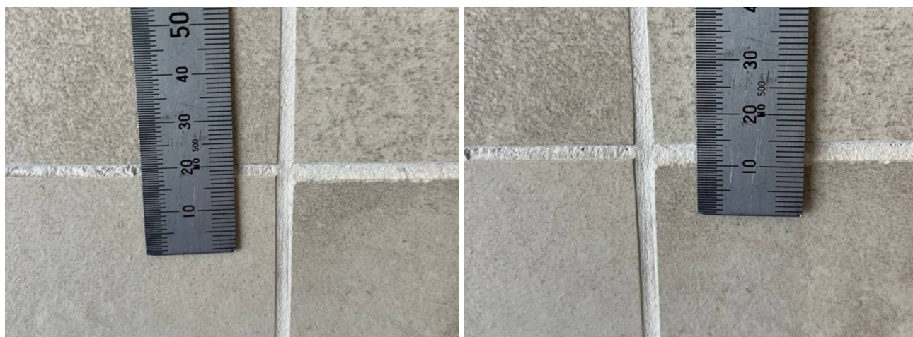
Фото №№ 110, 111 Разная ширина швов. Ширина 3 и 4 мм.
