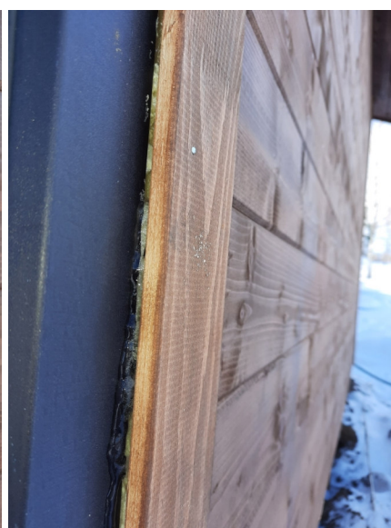
Фото №№ 49, 50 Блоки установлены с выносом в вентилируемый фасад. Конденсируется влага под обшивкой фасада.
