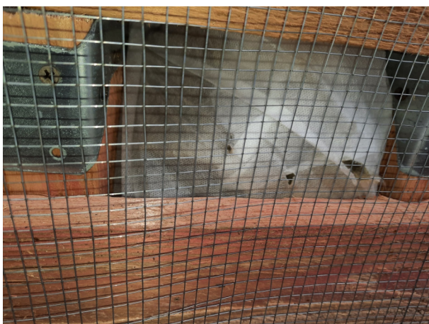
Фото №№ 13, 14 Утеплитель уложен неплотно.
