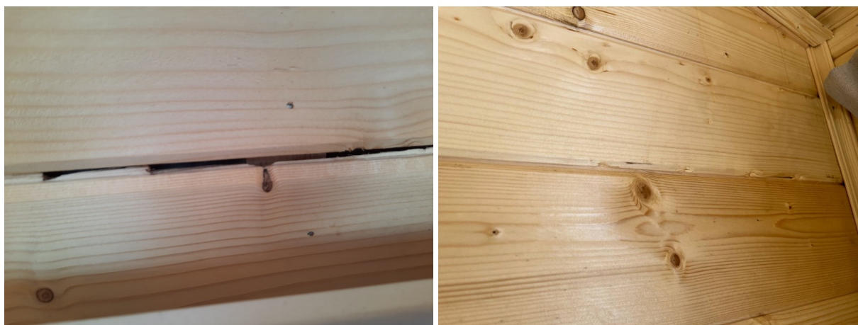
Фото №№ 83, 84 Повреждение ребер имитации бруса.
