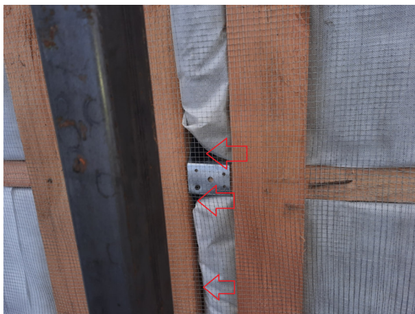
Фото №№ 15, 16 Утеплитель уложен неплотно.
