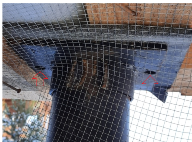
Фото №№ 43, 44 Оголовки не закреплены к обвязке дома.
