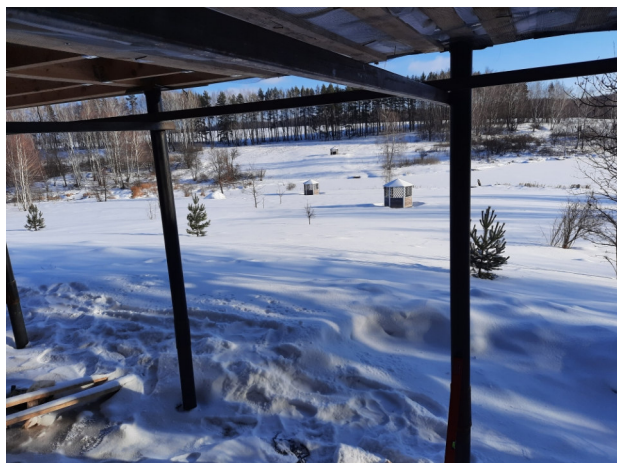
Фото №№ 37, 38 Отсутствуют укосины между сваями.
