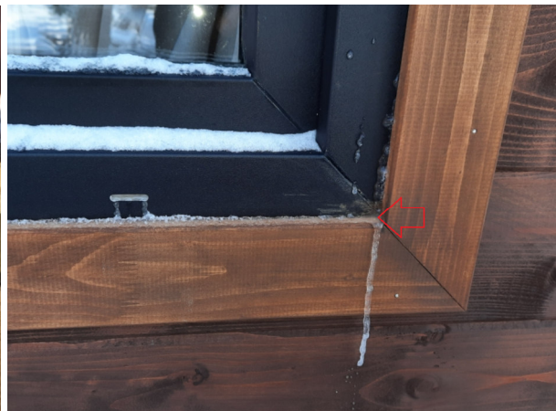
Фото №№ 47, 48 Оконные блоки установлены с выносом в вентилируемый фасад. Отливы отсутствуют. Влага попадает под обшивку фасада.
