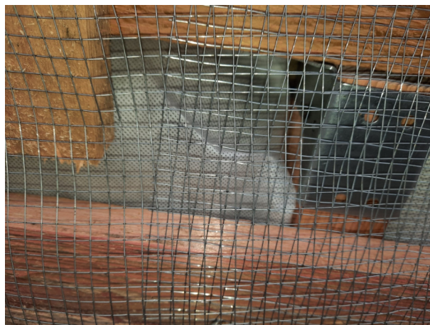
Фото №№ 11, 12 Утеплитель уложен неплотно.
