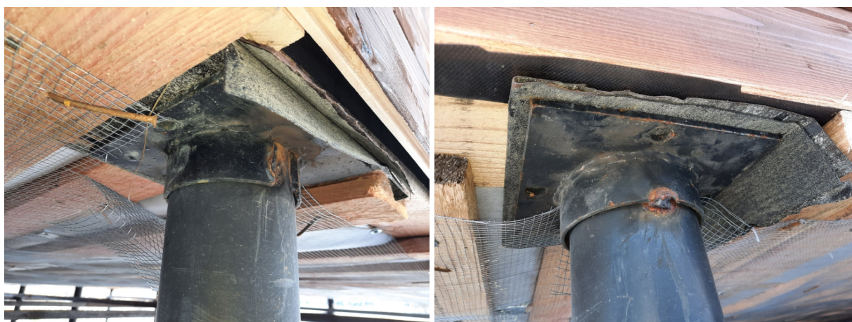
Фото №№ 25, 26 Разрывы и пропуски сетки от грызунов.
