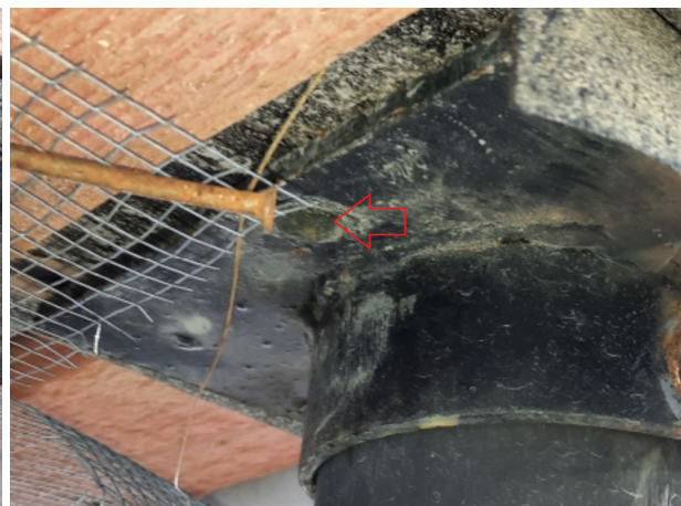
Фото №№ 39, 40 Оголовки не закреплены к обвязке дома.
