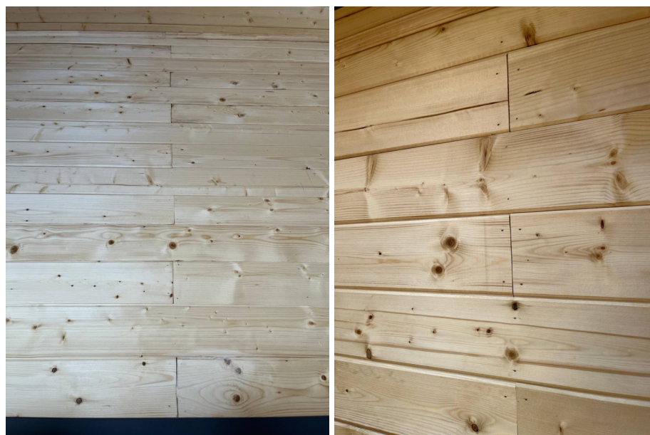
Фото №№ 81, 82 Стыковка с зазорами.
