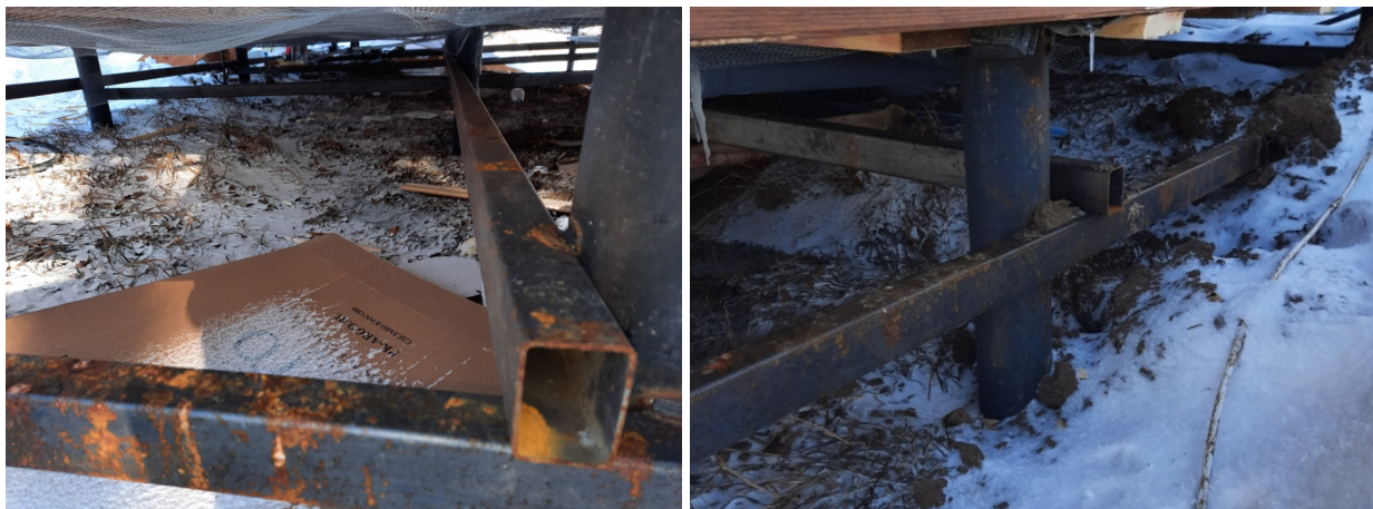
Фото №№ 29, 30 Профиль не окрашен, торцы не закрыты.
