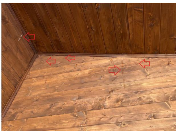
Фото № 103 Наледь на примыкании стен и потолка.
