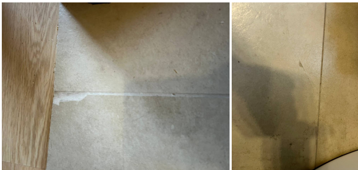
Фото №№ 106, 107 Скол и трещина.
