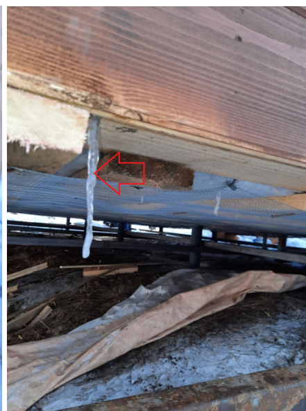
Фото №№ 51, 52 Конденсируется влага под обшивкой фасада.
