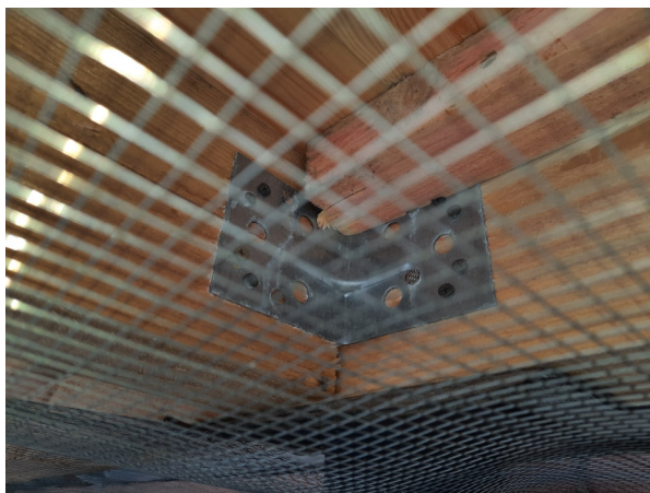
Фото №№ 3, 4 Крепление «черными» саморезами. Отсутствует гидроизоляционный слой.
