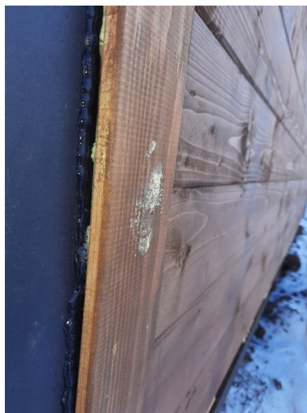
Фото №№ 51, 52 Конденсируется влага под обшивкой фасада.
