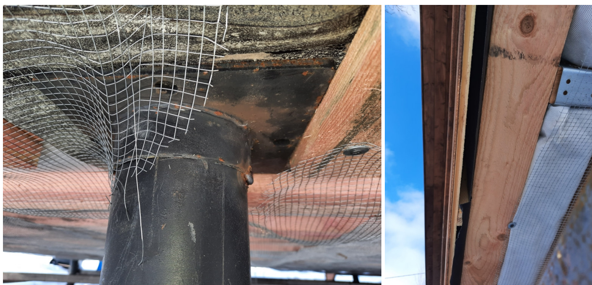
Фото №№ 23, 24 Разрывы и пропуски сетки от грызунов.
