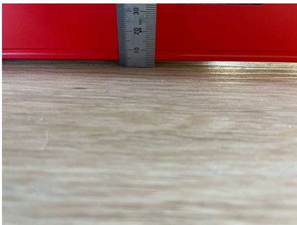
Фото №№ 92, 93 Отклонения от плоскости 4 и 6 мм.
