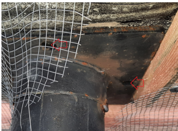
Фото №№ 41, 42 Оголовки не закреплены к обвязке дома.
