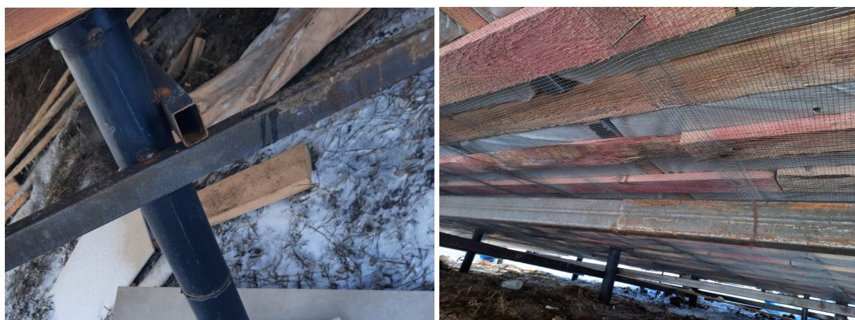
Фото №№ 31, 32 Профиль не окрашен, торцы не закрыты.
