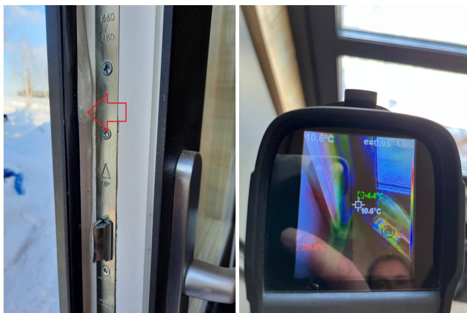
Фото №№ 73, 74 Намерзание льда между полотном и коробом. Промерзание по периметру дверного блока.
