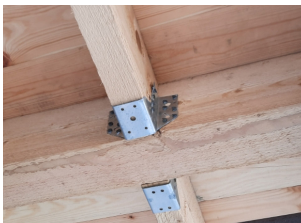
Фото №№ 9, 10 Крепление «черными» саморезами. Отсутствует гидроизоляционный слой.
