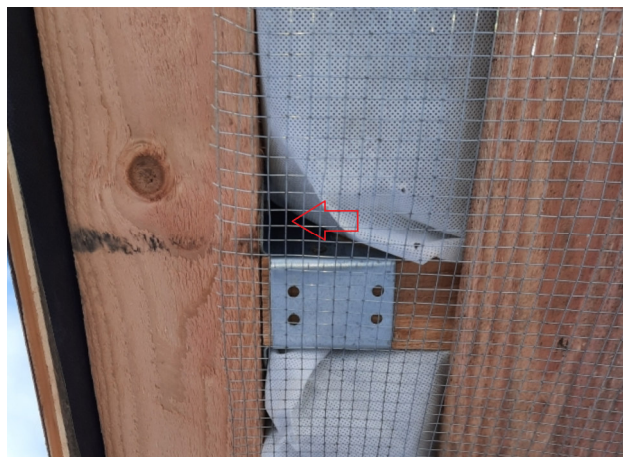
Фото №№ 17, 18 Утеплитель уложен неплотно.
