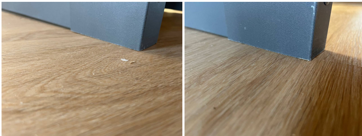
Фото №№ 94, 95 Полотна дверных блоков открываются с затруднением.
