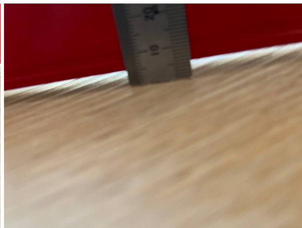
Фото №№ 92, 93 Отклонения от плоскости 4 и 6 мм.
