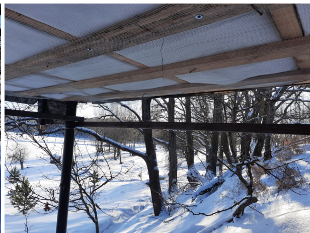
Фото №№ 37, 38 Отсутствуют укосины между сваями.
