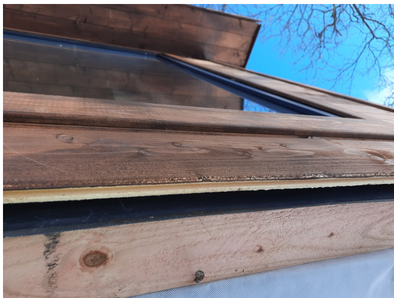
Фото №№ 45, 46 Оконные блоки установлены с выносом в вентилируемый фасад. Отливы отсутствуют.
