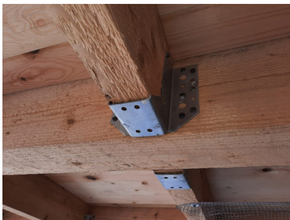
Фото №№ 5, 6 Крепление «черными» саморезами. Отсутствует гидроизоляционный слой.
