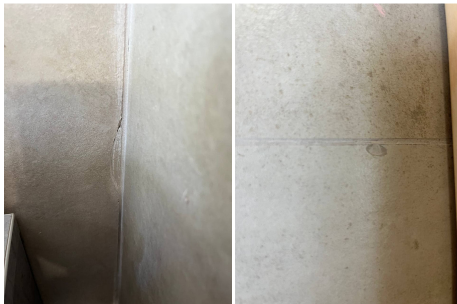
Фото №№ 104, 105 Повреждения плит керамогранита.
