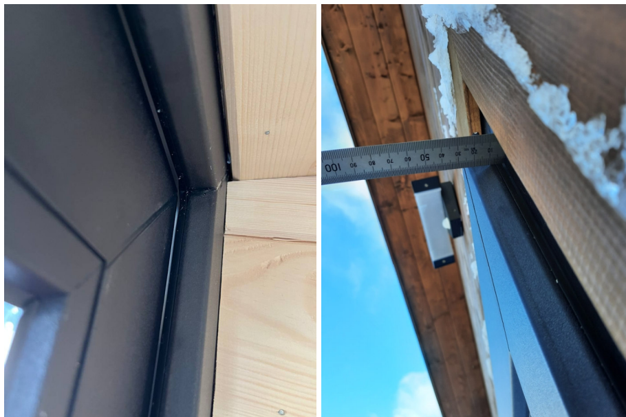
Фото №№ 71, 72 Зазоры между полотном и коробом дверного блока.
