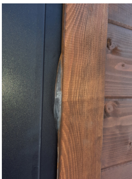
Фото №№ 49, 50 Блоки установлены с выносом в вентилируемый фасад. Конденсируется влага под обшивкой фасада.
