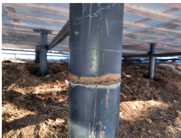
Фото № 36 Нарастивание свай выполнено без усиливающих накладок или муфт.
