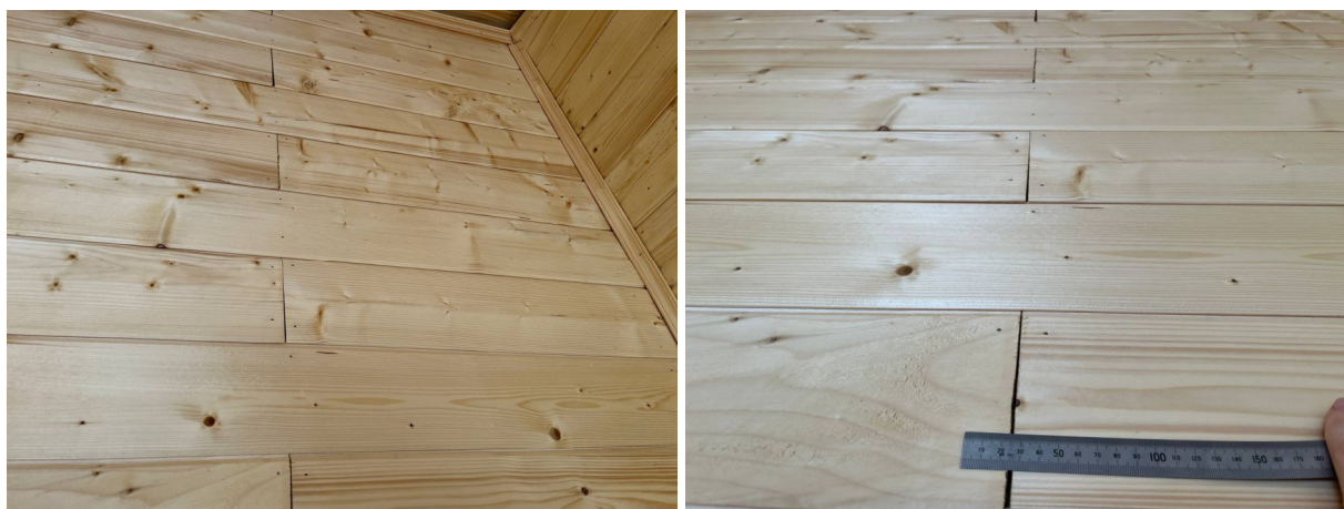
Фото №№ 77, 78 Стыковка с зазорами.
