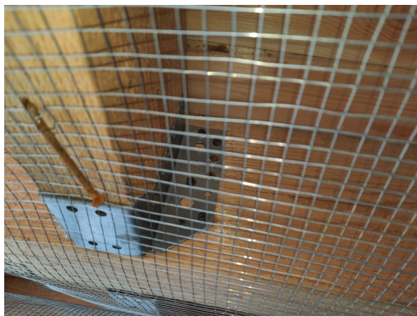
Фото №№ 3, 4 Крепление «черными» саморезами. Отсутствует гидроизоляционный слой.
