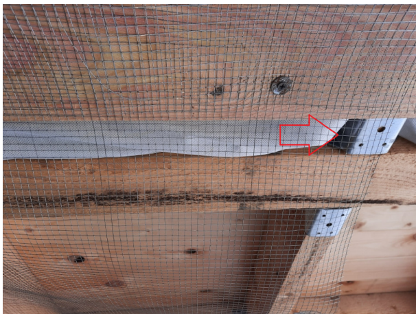
Фото №№ 11, 12 Утеплитель уложен неплотно.
