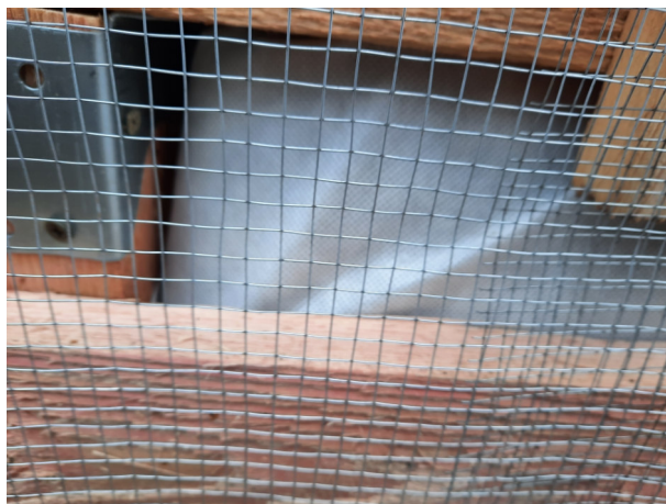
Фото № 21 Утеплитель уложен неплотно.
