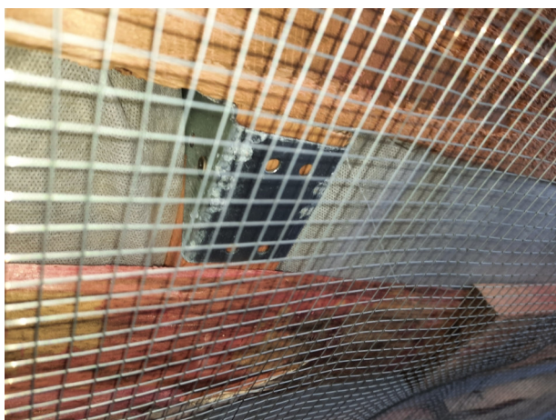
Фото №№ 19, 20 Утеплитель уложен неплотно.
