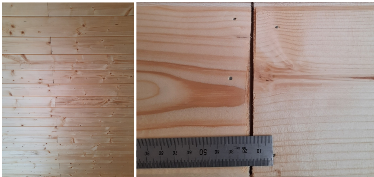
Фото №№ 79, 80 Стыковка с зазорами.
