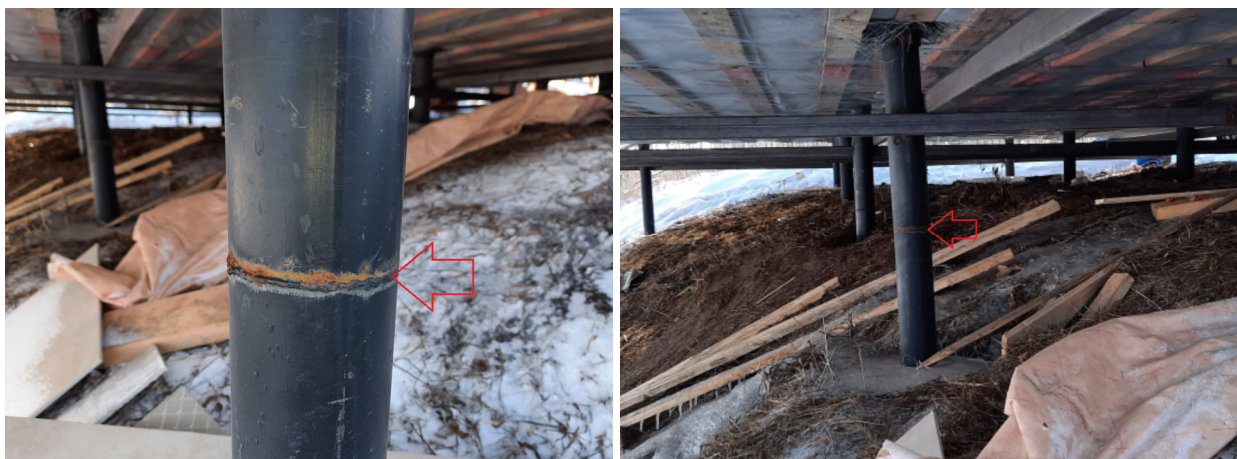
Фото №№ 34, 35 Нарастивание свай выполнено без усиливающих накладок или муфт.
