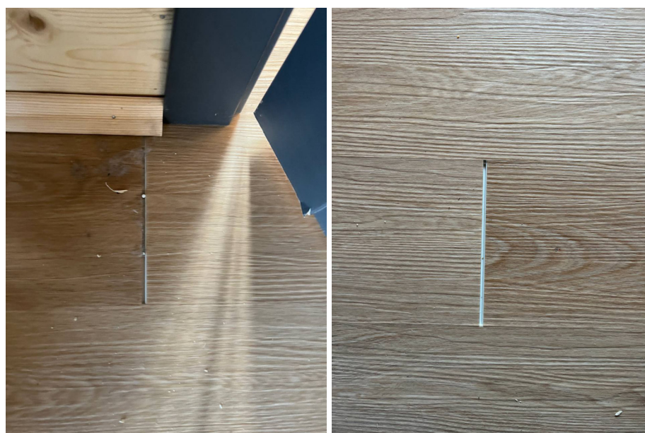
Фото №№ 87, 88 Зазоры между планками напольного покрытия.
