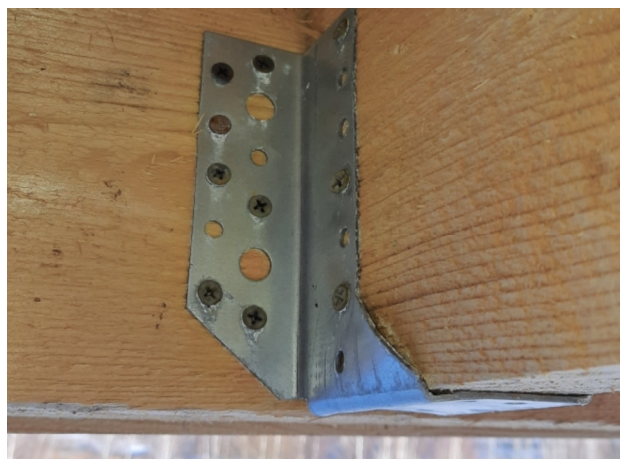
Фото №№ 7, 8 Крепление «черными» саморезами. Отсутствует гидроизоляционный слой.
