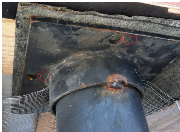
Фото №№ 39, 40 Оголовки не закреплены к обвязке дома.
