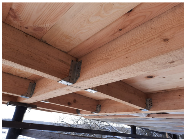
Фото №№ 5, 6 Крепление «черными» саморезами. Отсутствует гидроизоляционный слой.
