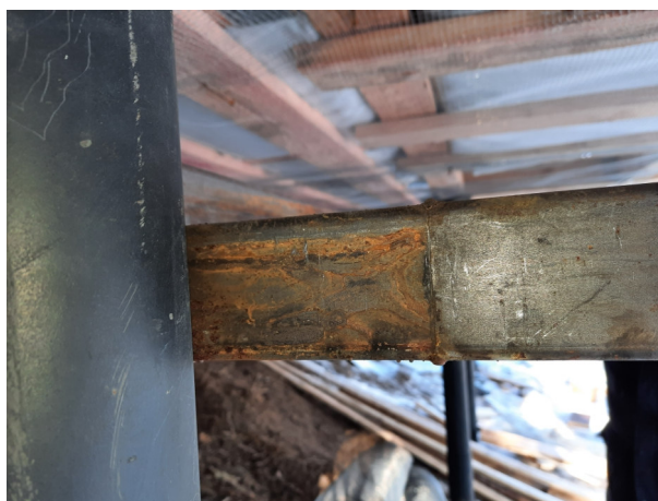
Фото № 33 Профиль не окрашен. Стык не проварен.
