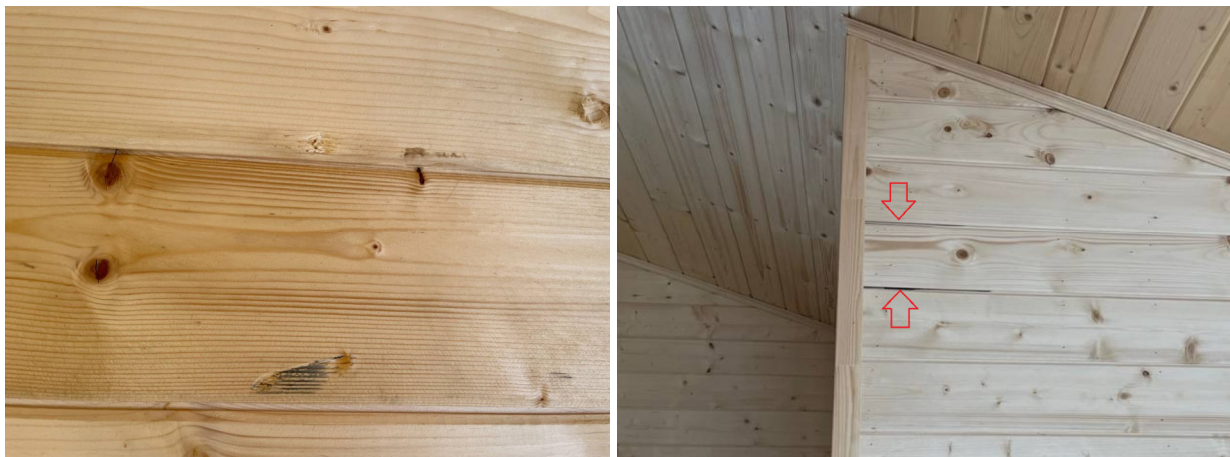
Фото №№ 85, 86 Повреждение и загрязнение поверхности планки имитации бруса. Заломы ребер планки.
