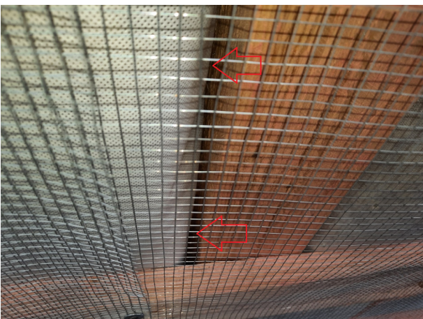
Фото №№ 15, 16 Утеплитель уложен неплотно.
