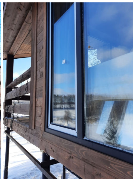
Фото №№ 45, 46 Оконные блоки установлены с выносом в вентилируемый фасад. Отливы отсутствуют.
