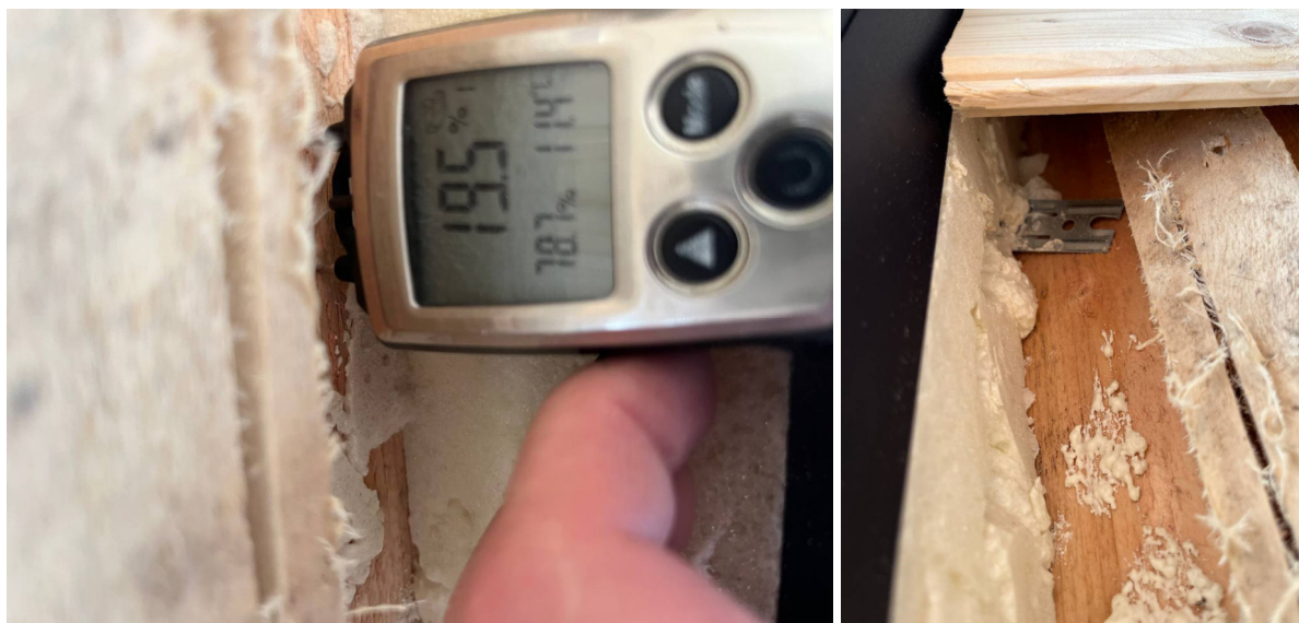
Фото 57, 58 Повышенная влажность каркаса оконного проема.
