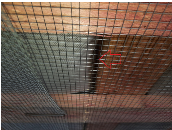
Фото №№ 13, 14 Утеплитель уложен неплотно.
