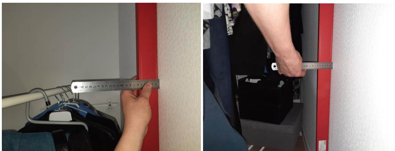
Фото №№ 14, 15 Неровности плавного очертания стен
