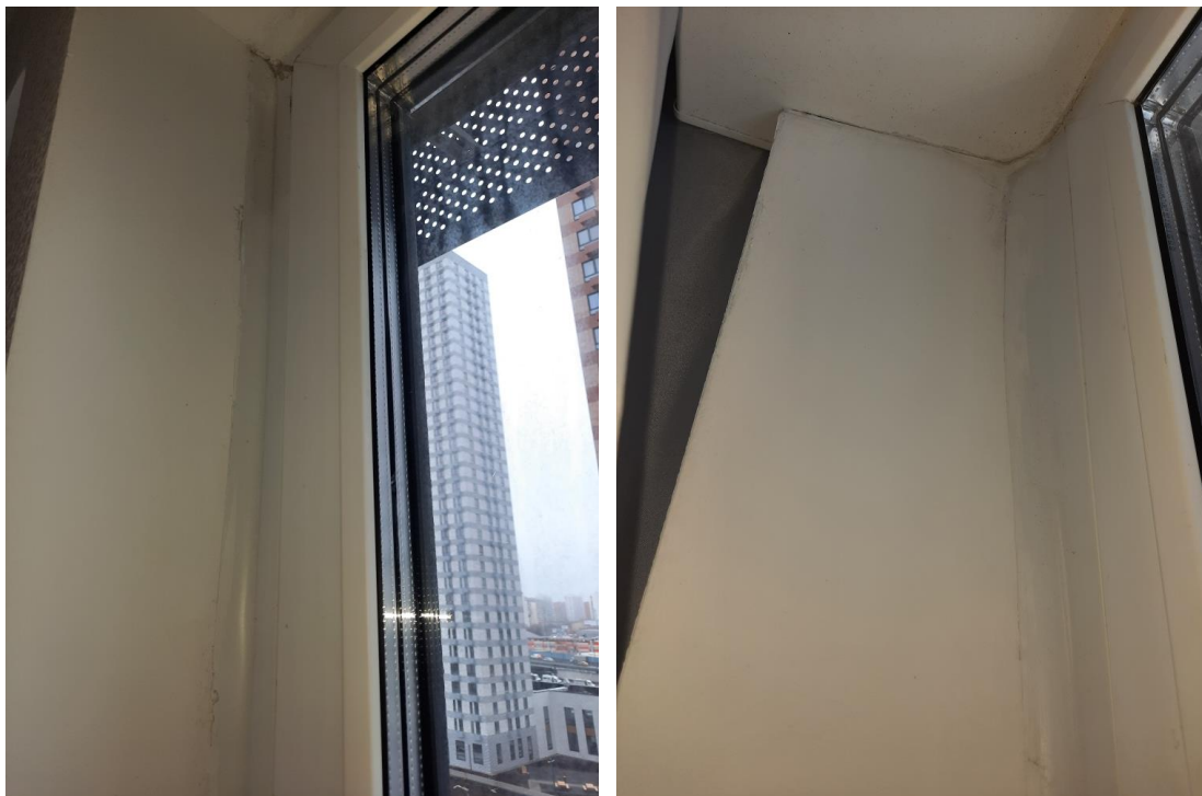
Фото №№ 22, 23 Некачественно выполнены откосы и монтированы нащельники
