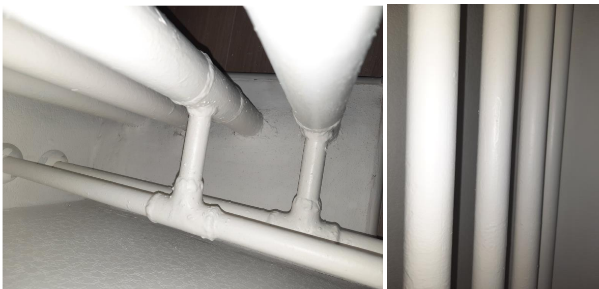
Фото №№ 47, 48 Некачественная покраска труб отопления
