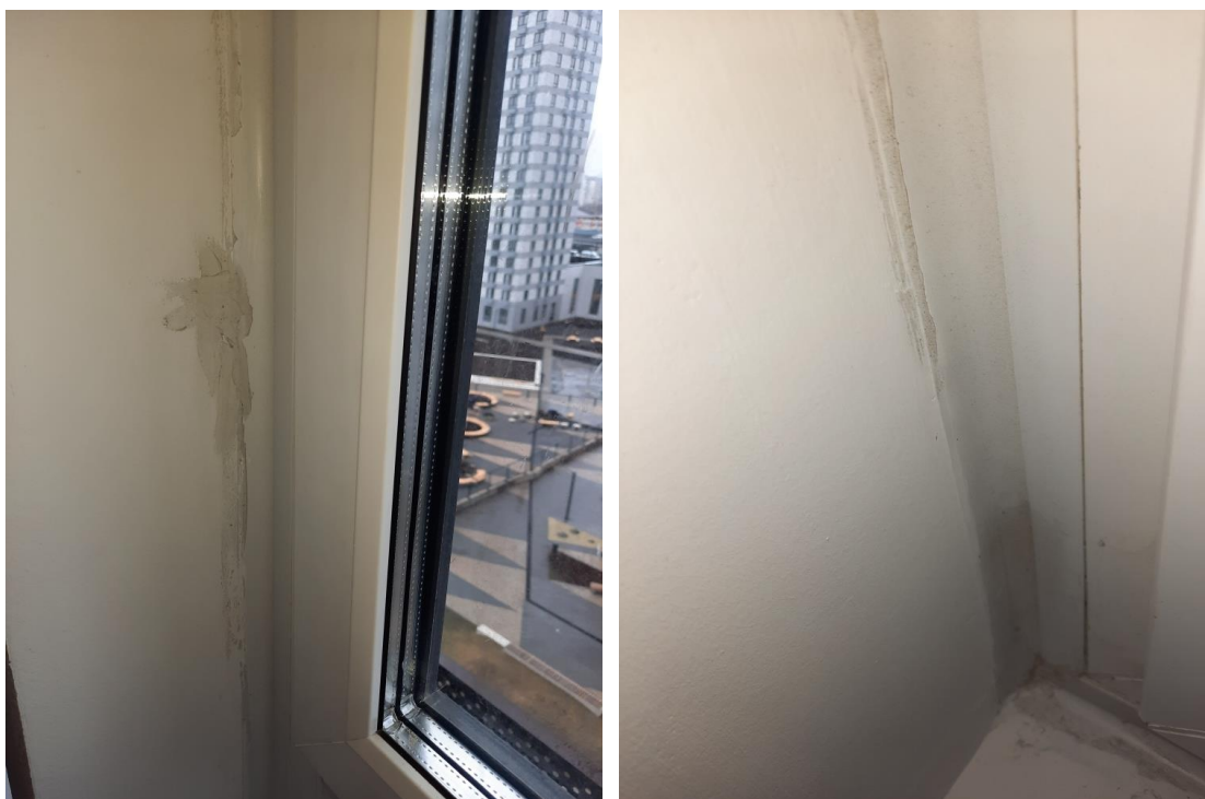
Фото №№ 20, 21 Некачественно выполнены откосы и монтированы нащельники
