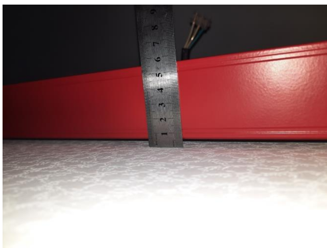
Фото №№ 34, 35 Неровности плавного очертания стен
