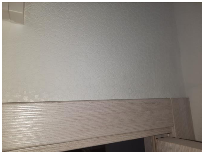
Фото №№ 25, 26 Зазор, загрязнение. Наличники не в одной плоскости
