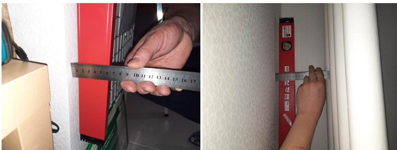
Фото №№ 38, 39 Отклонение плоскости стены от вертикали
