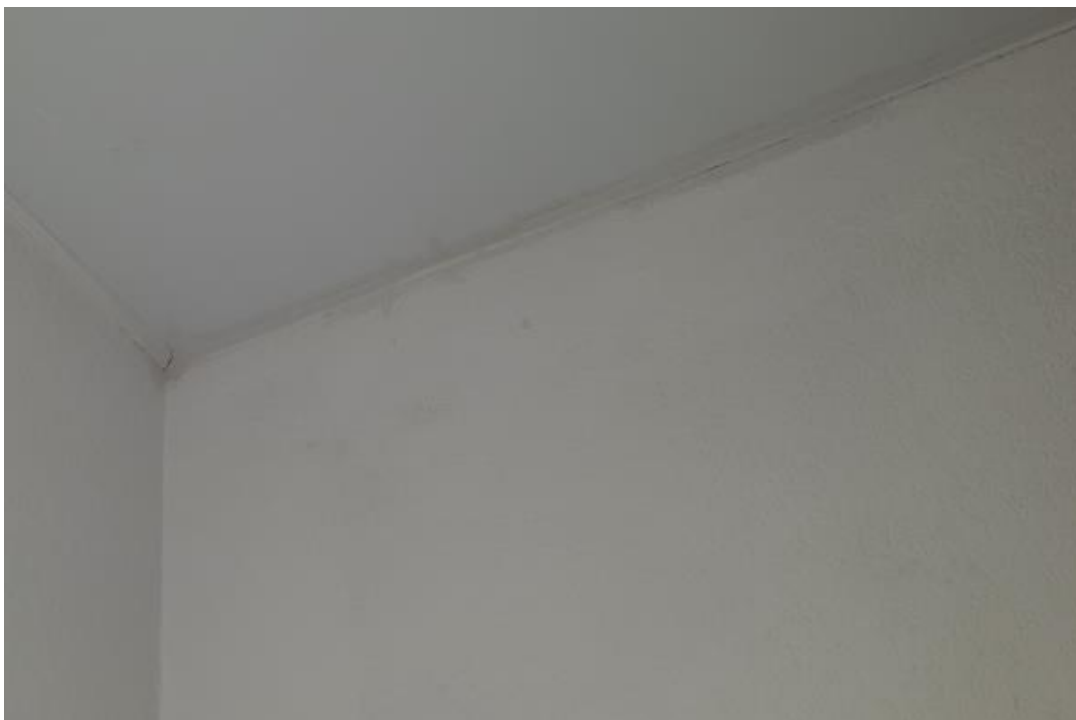
Фото № 7 Загрязнения. Зазоры на угловых примыканиях молдинга натяжного потолка
