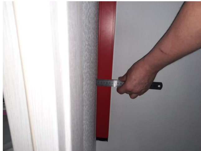
Фото №№ 10, 11 Неровность плавного очертания стены.
