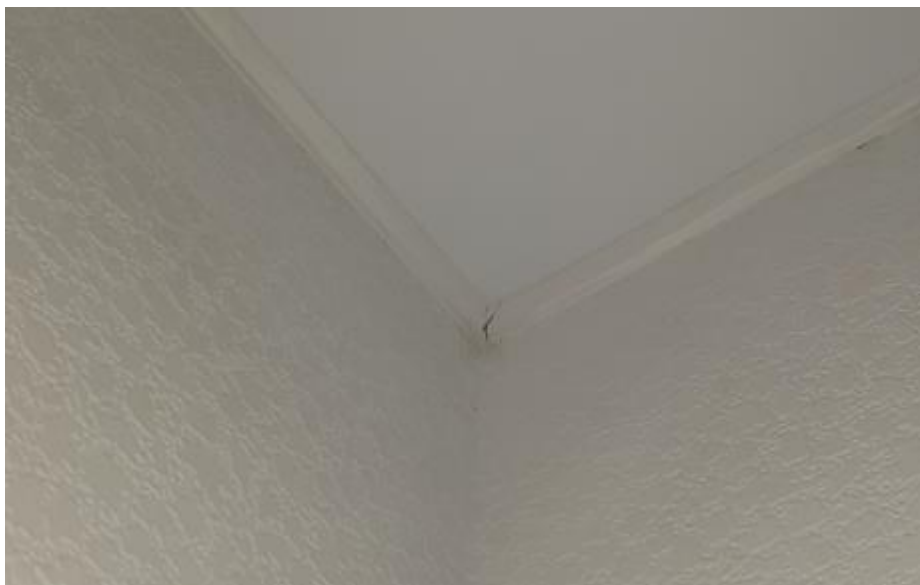
Фото № 31 Зазоры на угловых примыканиях молдинга натяжного потолка.
