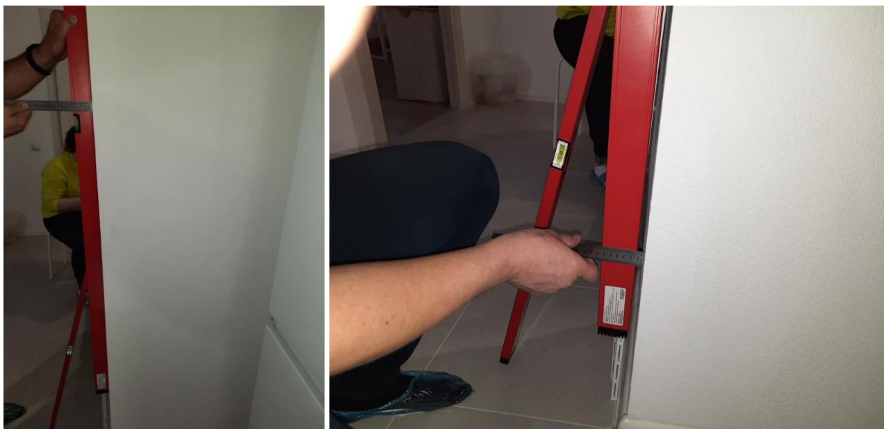
Фото №№ 36, 37 Неровности плавного очертания стен. Отклонение от вертикали
