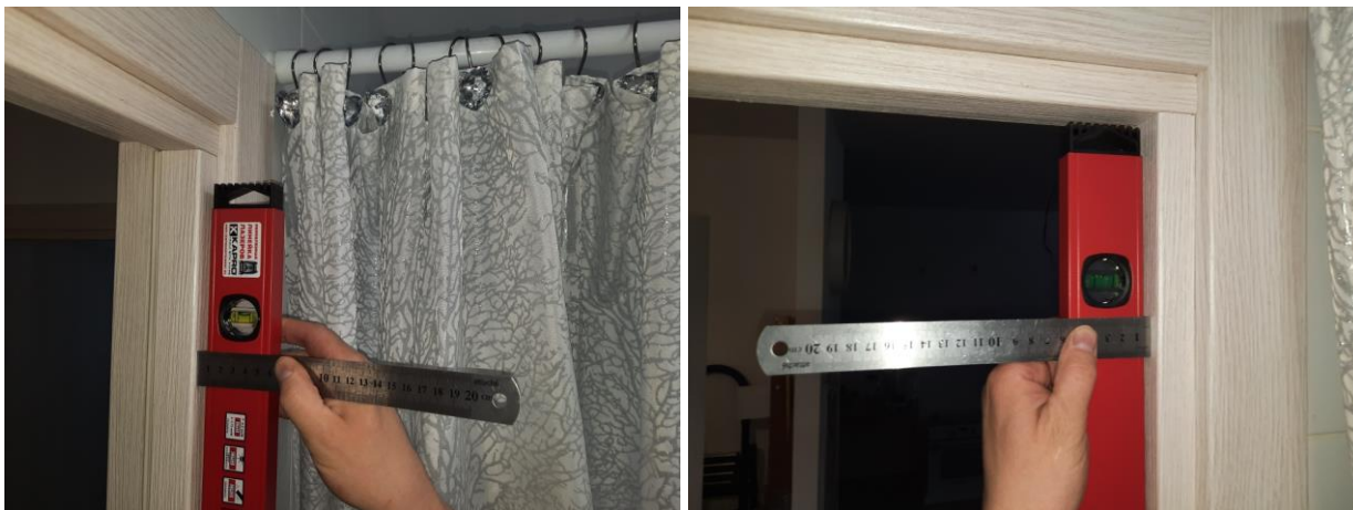
Фото №№ 58, 59 Отклонение дверного короба от вертикали. Отклонение от прямолинейности дверного короба
