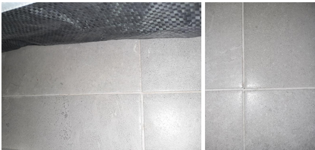
Фото №№ 5, 6 Разница ширины шва более 1 мм
