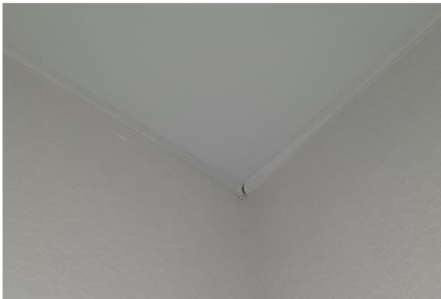
Фото № 9 Загрязнения. Зазоры на угловых примыканиях молдинга натяжного потолка
