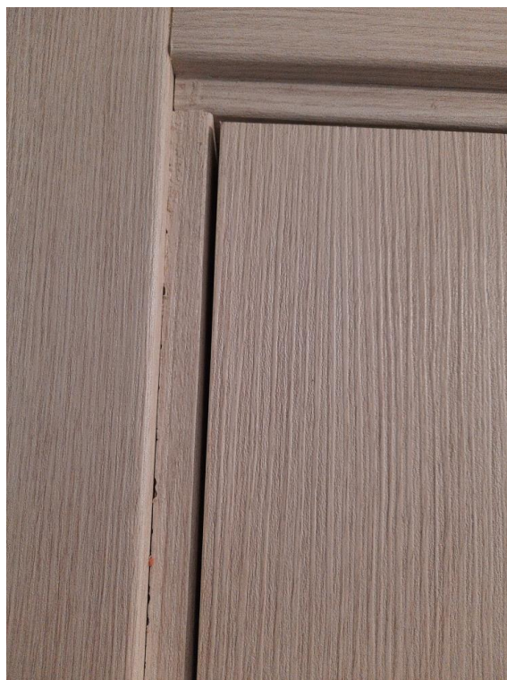
Фото №№ 27, 28 Загрязнения герметиком, зазоры
