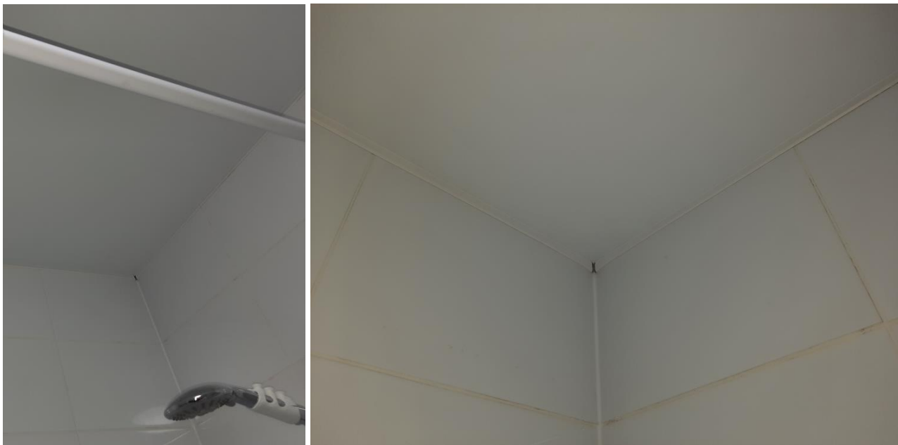
Фото №№ 72, 73 Зазоры на угловых примыканиях молдинга натяжного потолка.
