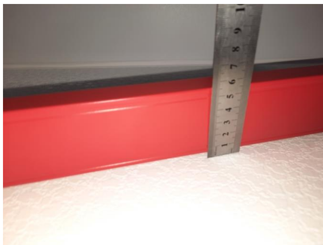
Фото №№ 16, 17 Неровности плавного очертания стен
