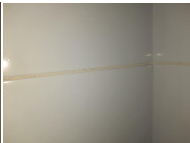
Фото №№ 64, 65 Некачественная затирка межплиточных швов
