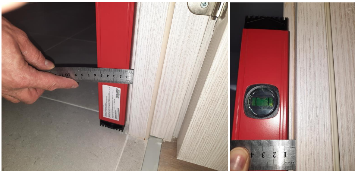
Фото №№ 56, 57 Отклонение дверного короба от вертикали
