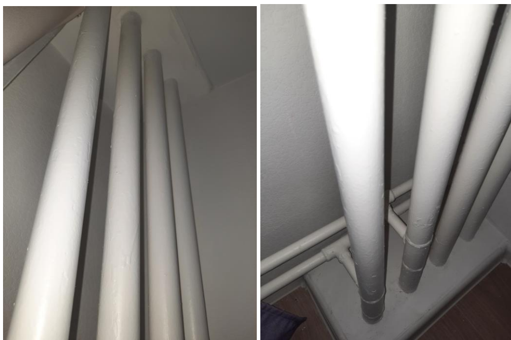
Фото №№ 49, 50 Некачественная покраска труб отопления
