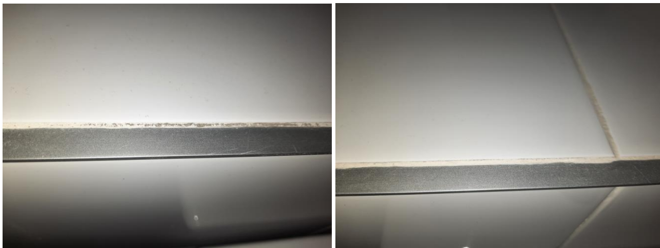
Фото №№ 68, 69 Некачественная затирка межплиточных швов
