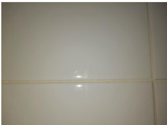
Фото №№ 64, 65 Некачественная затирка межплиточных швов
