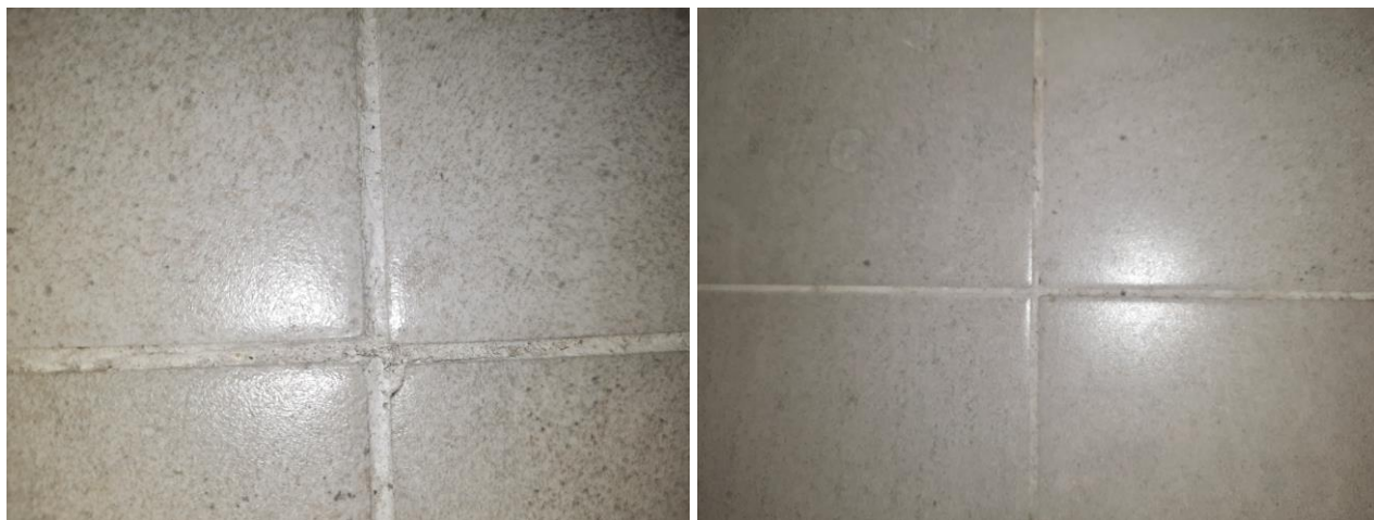
Фото №№ 60, 61 Некачественная затирка межплиточных швов
