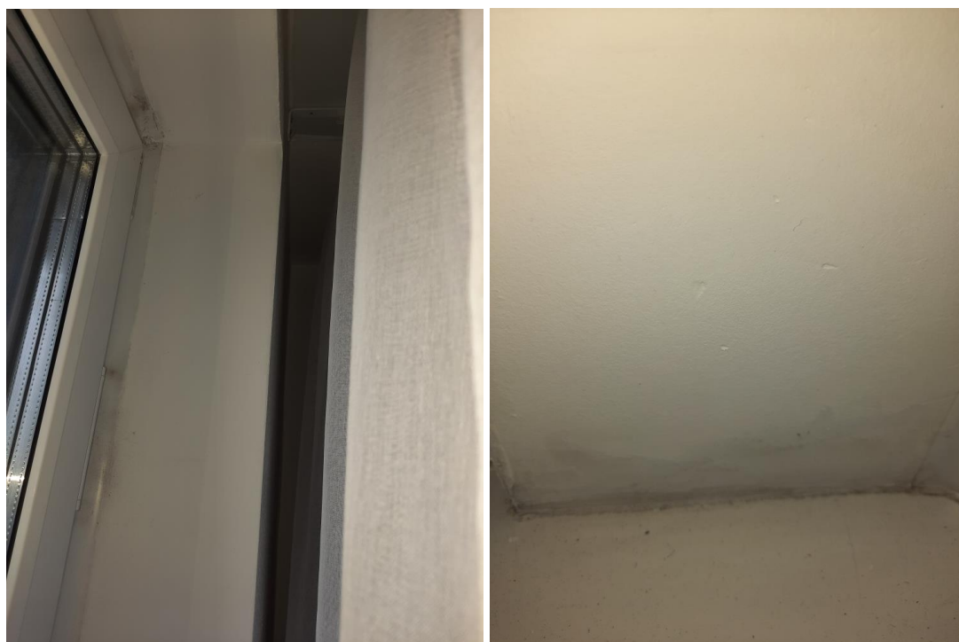
Фото №№ 40, 41 Некачественная подготовка откосов и примыкания оконного блока
