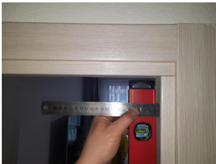
Фото № 24 Отклонение от прямолинейности дверного короба
