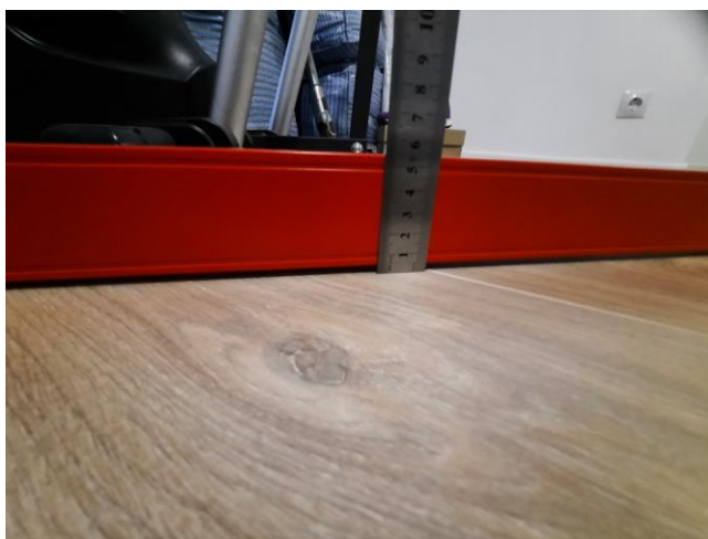
Фото №№ 45, 46 Отклонения поверхности напольного покрытия
