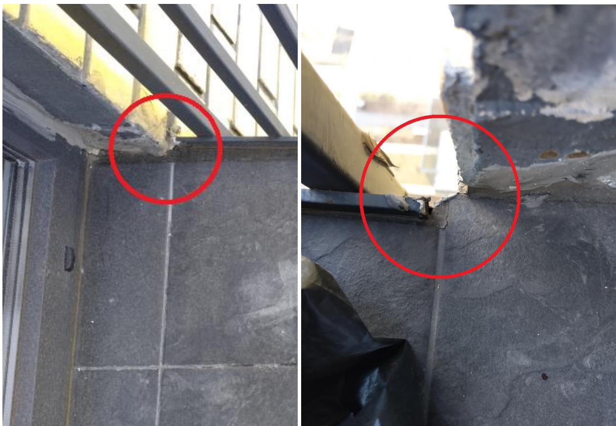
Фото №№ 17, 18 Балкон исследуемой квартиры. Зазоры между листом и стеной
