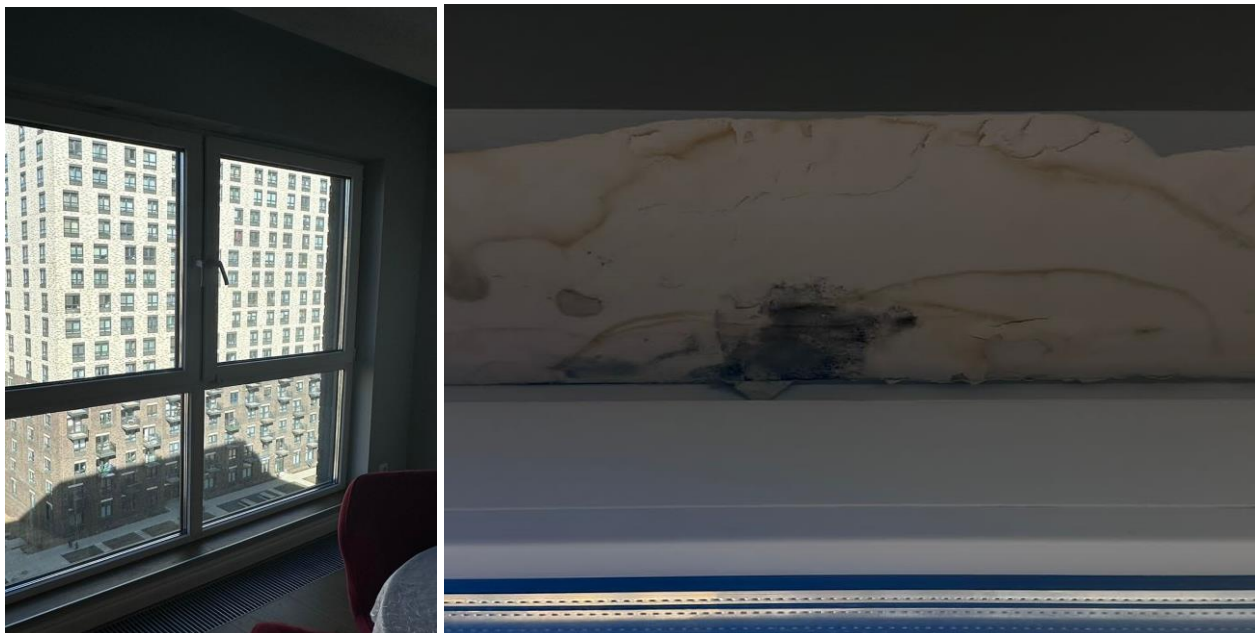
Фото №№ 1, 2 Общий вид оконного блока. Дефекты на верхнем откосе
