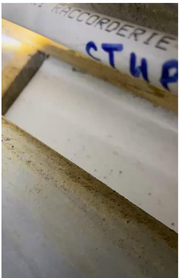
Фото №№ 13, 14 Загрязнения на стояке канализации
