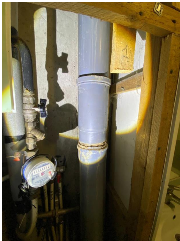
Фото №№ 9, 10 Общий вид канализационного стояка. Следы подтёков на стояке
