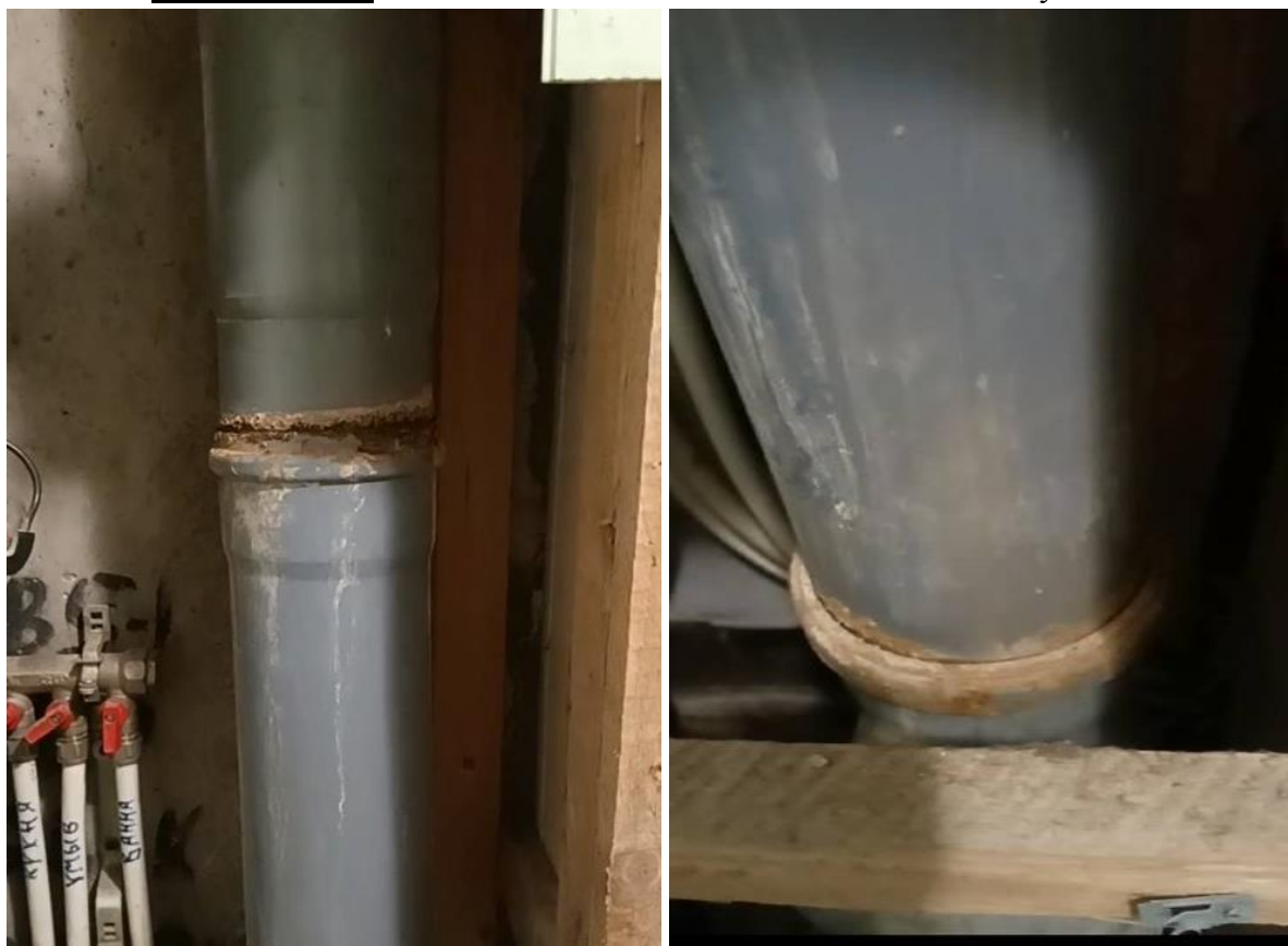
Фото №№ 3, 4 Выдавливание канализационных стоков из стыковых соединений
