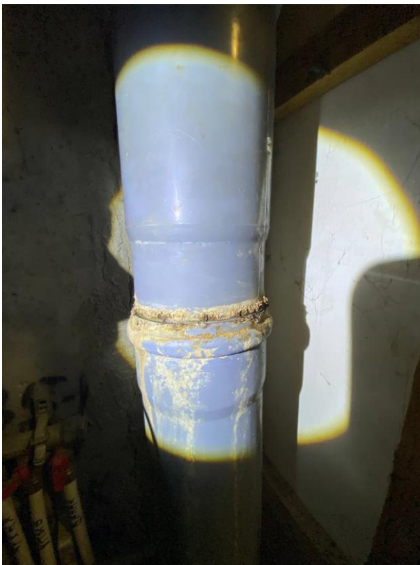
Фото №№ 11, 12 Следы подтёков на стояке канализации. Скопление грязевого налёта на примыканиях секций канализационного стояка
