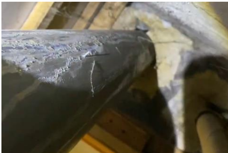
Фото № 15 Следы подтёков на стояке канализации
