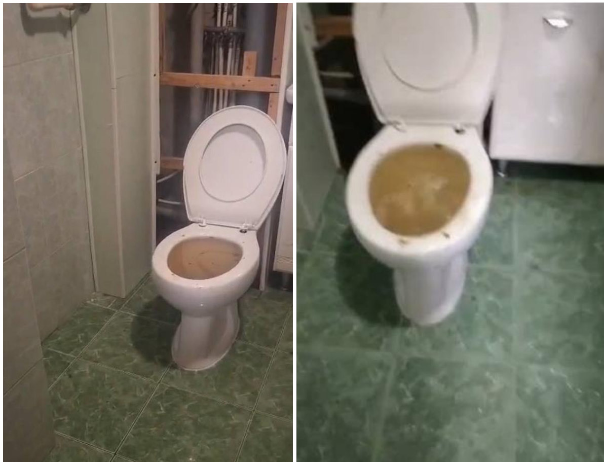
Фото №№ 1, 2 Выдавливание канализационных стоков из унитаза
