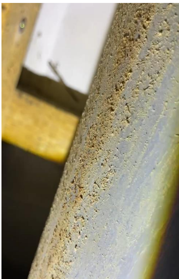
Фото №№ 13, 14 Загрязнения на стояке канализации
