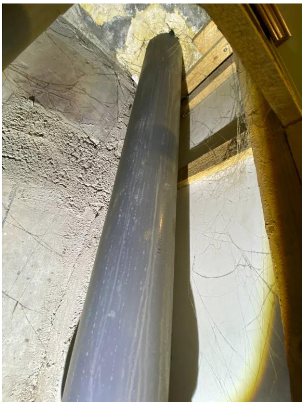
Фото №№ 9, 10 Общий вид канализационного стояка. Следы подтёков на стояке
