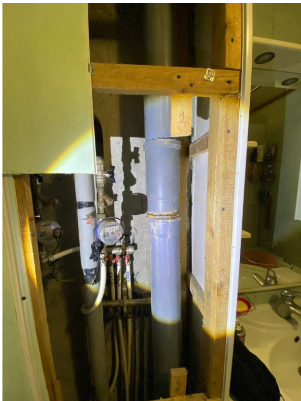
Фото №№ 11, 12 Следы подтёков на стояке канализации. Скопление грязевого налёта на примыканиях секций канализационного стояка
