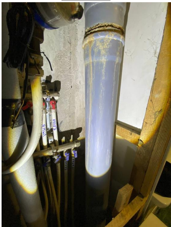
Фото №№ 16, 17 Следы подтёков на стояке канализации
