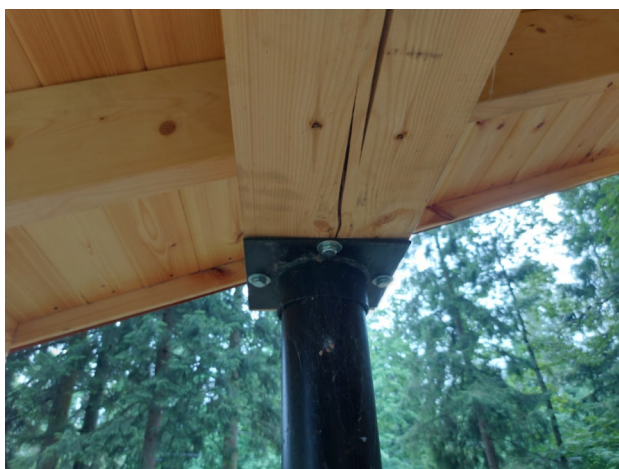
Фото №№ 108, 109 Отсутствует гидроизоляционный слой между металлом и древесиной.
