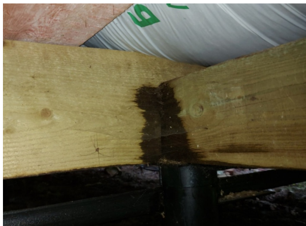
Фото №№ 82, 83 Подрезка балок более четверти высоты поперечного сечения элементов.
