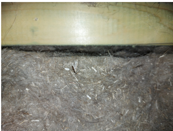
Фото №№ 40, 41 Утеплитель замят, уложен с зазорами. Пароизоляционный слой отсутствует.
