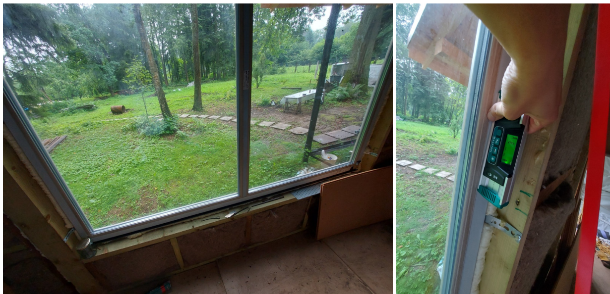
Фото №№ 110, 111 Общий вид оконного блока. Отклонение от вертикали 3 мм.
