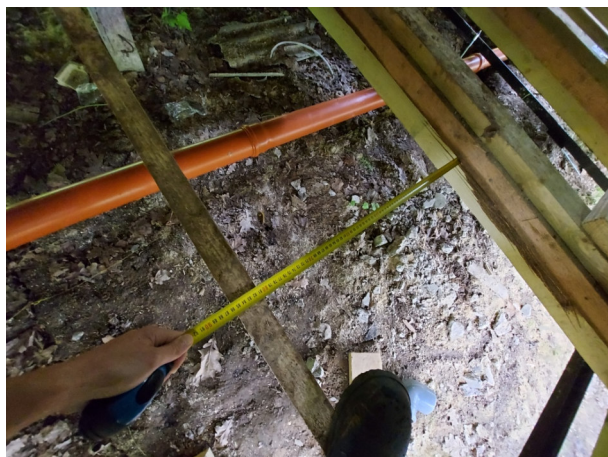
Фото №№ 62, 63 Расстояние между балками перекрытия 810 мм.
