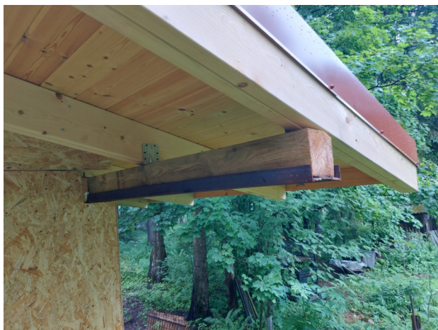
Фото №№ 106, 107 Отсутствует гидроизоляционный слой между металлом и древесиной.
