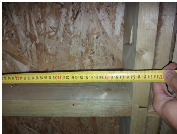
Фото №№ 51, 52 Расстояния между стойками 847 и 1 152 мм.
