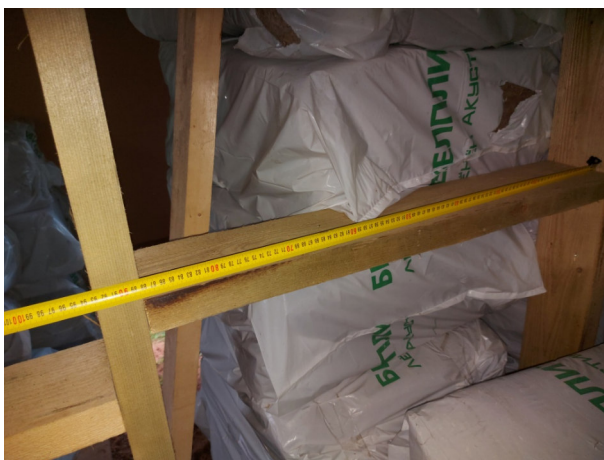
Фото №№ 60, 61 Расстояния между стойками 720 и 880 мм.
