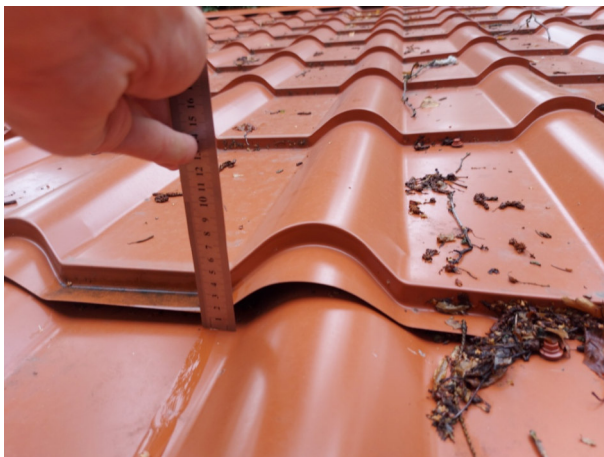
Фото №№ 147, 148 Смещения профилей листов. Зазоры до 25 мм.
