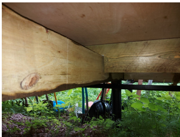
Фото №№ 80, 81 Подрезка балок более четверти высоты поперечного сечения элементов.
