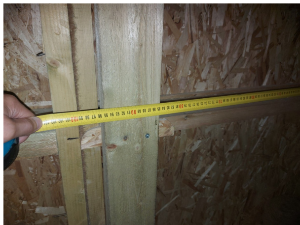
Фото №№ 51, 52 Расстояния между стойками 847 и 1 152 мм.
