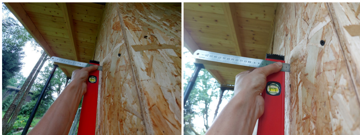
Фото №№ 126, 127 Отклонения от вертикали 14 и 13 мм.
