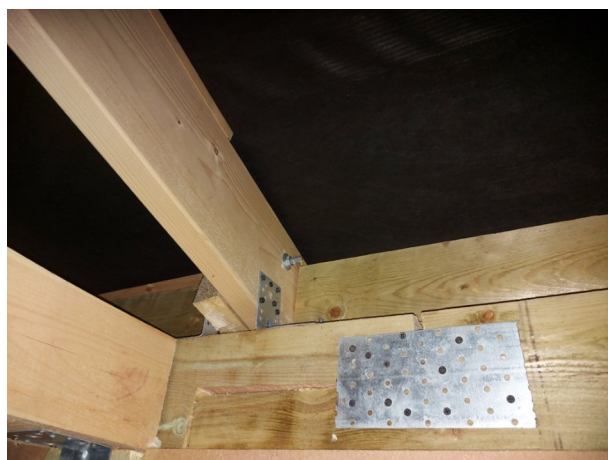
Фото №№ 21, 22 Крепление на фосфатированные («черные») саморезы.
