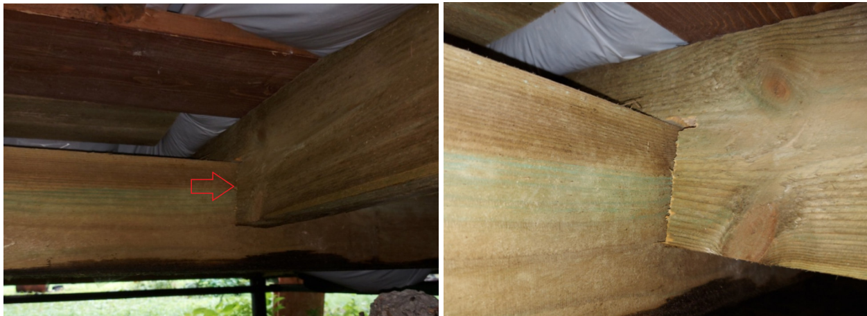
Фото №№ 76, 77 Подрезка балок более четверти высоты поперечного сечения элементов.
