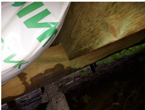
Фото №№ 82, 83 Подрезка балок более четверти высоты поперечного сечения элементов.
