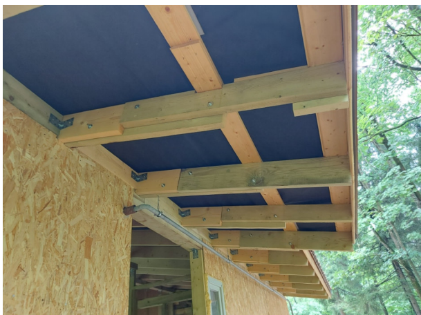
Фото №№ 70, 71 Стыки наращенных стропил располагаются не над опорой.
