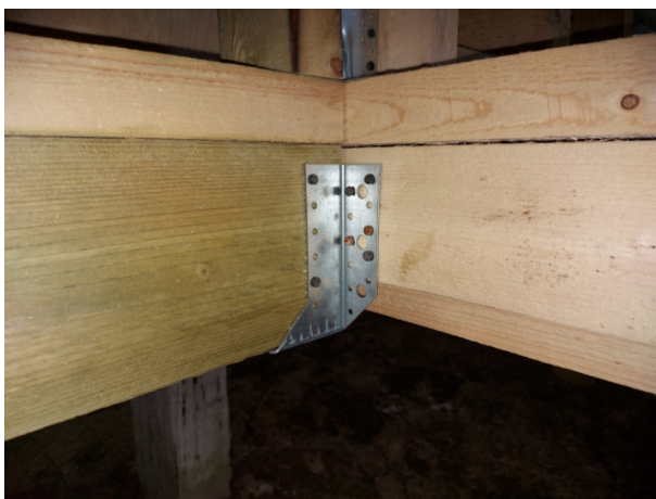
Фото №№ 15, 16 Крепление на фосфатированные («черные») саморезы.
