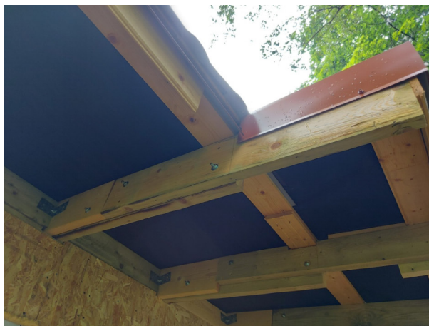
Фото № 72 Стыки наросщенных стропил располагаются не над опорой.
