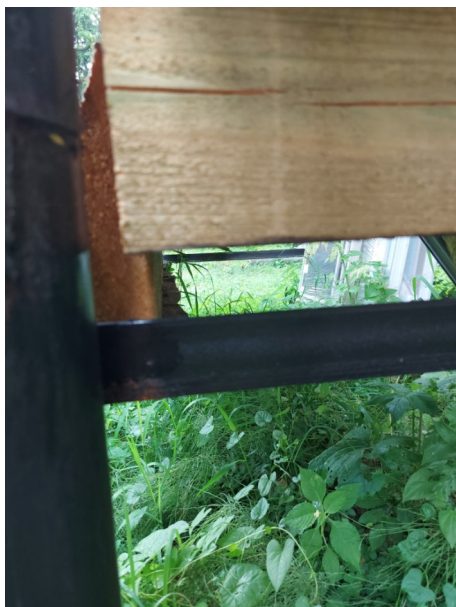
Фото №№ 100, 101 Угол обвязки не имеет опоры.
