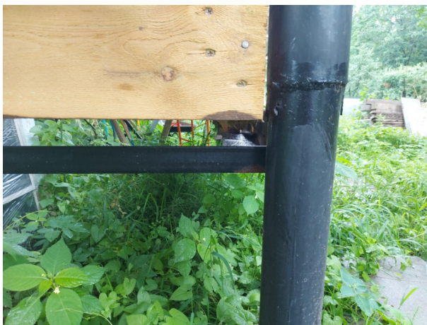
Фото №№ 98, 99 Угол обвязки не имеет опоры.
