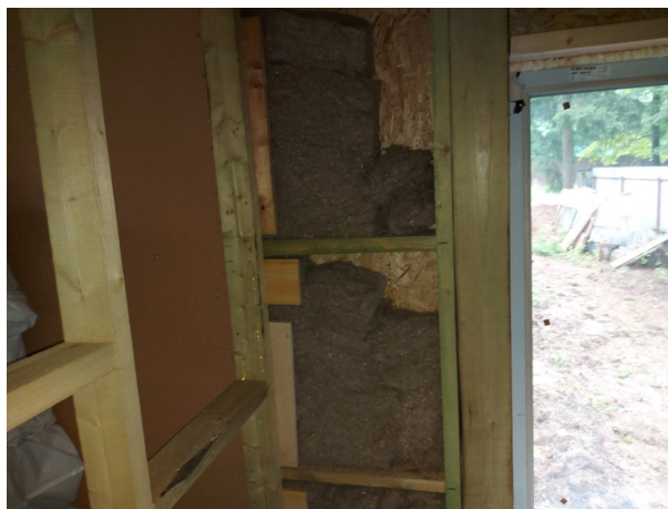
Фото №№ 31, 32 Утепление из кусков. Плиты утеплителя замяты, уложены с зазорами. Пароизоляционный слой отсутствует.
