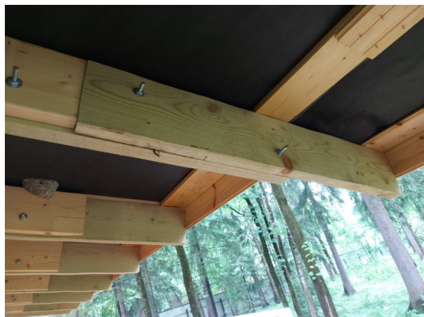
Фото №№ 70, 71 Стыки наращенных стропил располагаются не над опорой.
