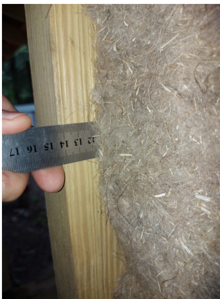
Фото №№ 33, 34 Утеплитель замят. Толщина слоя утепления 120 мм. Пароизоляционный слой отсутствует.
