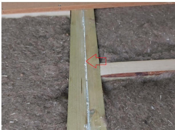
Фото № 46 Сквозные зазоры между сплоченными стойками.
