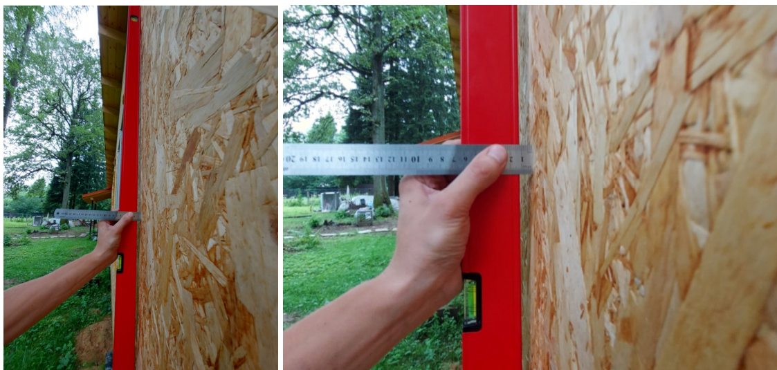
Фото №№ 128, 129 Неровность глубиной 11 мм.
