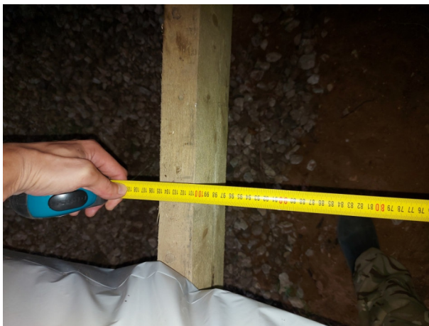
Фото №№ 66, 67 Расстояния между балками перекрытия 660 и 1 005 мм.
