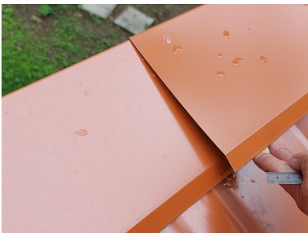
Фото №№ 137, 138 Торцевая планка закреплена некачественно.
