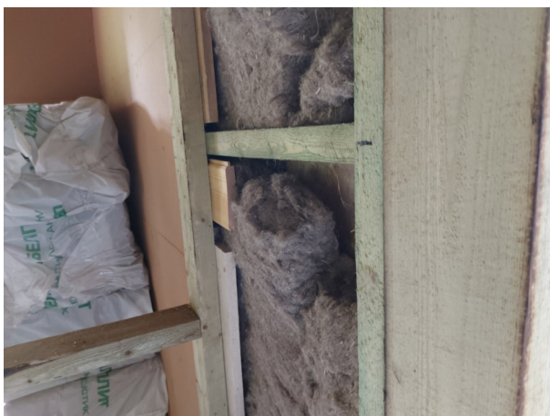
Фото №№ 44, 45 Утеплитель замят, уложен с зазорами. Пароизоляционный слой отсутствует.
