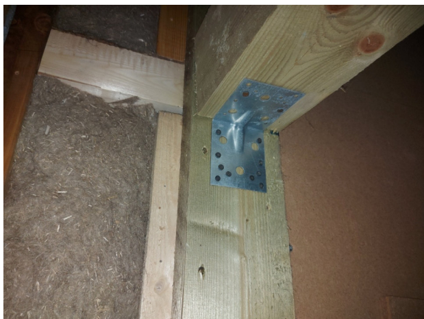
Фото №№ 7, 8 Крепление на фосфатированные («черные») саморезы.
