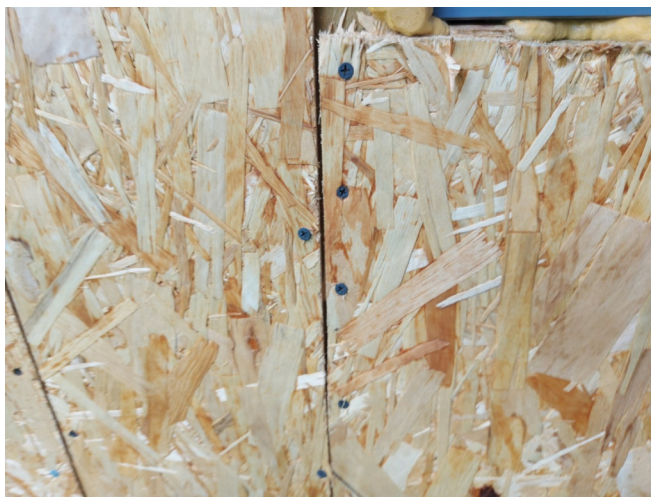
Фото № 121 Крепление ОСП на фосфатированные (черные) саморезы.
