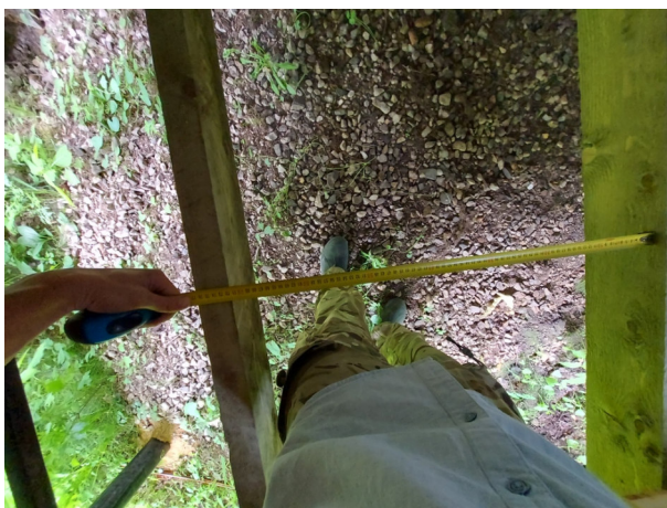
Фото №№ 64, 65 Расстояние между балками перекрытия 710 мм.
