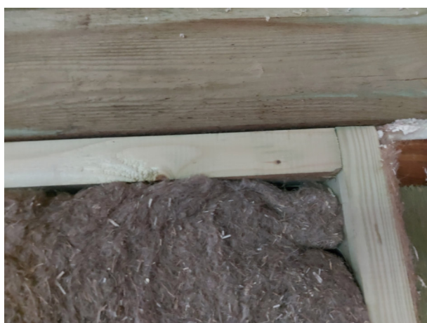
Фото №№ 37, 38 Утеплитель замят, уложен с зазорами. Пароизоляционный слой отсутствует.
