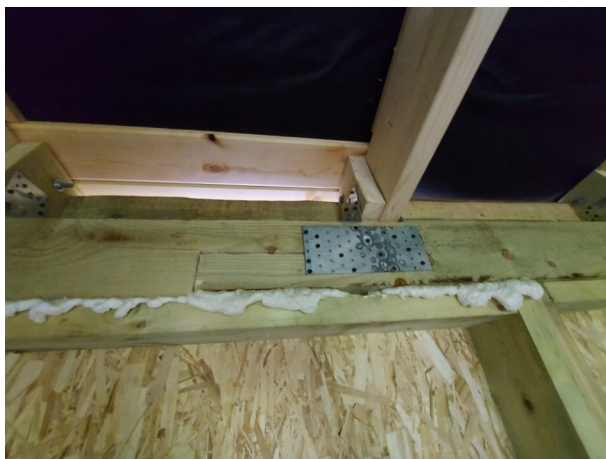
Фото № 69 Стыковое соединение не над вертикальной опорой.
