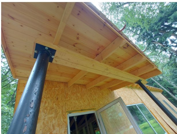
Фото №№ 106, 107 Отсутствует гидроизоляционный слой между металлом и древесиной.
