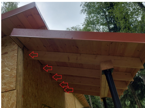
Фото № 27 Стропила опираются на обшивку из ОСП, не имеют опоры на силовом каркасе.
