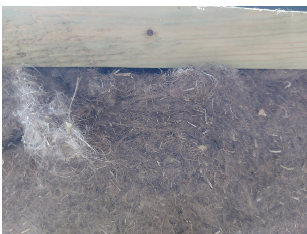
Фото №№ 42, 43 Утеплитель замят, уложен с зазорами. Пароизоляционный слой отсутствует.
