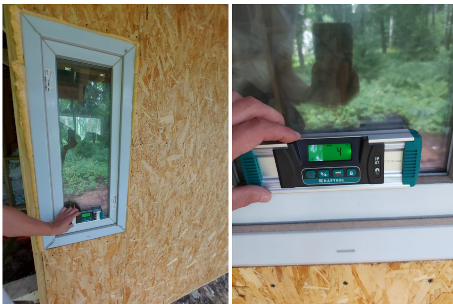
Фото №№ 117, 118 Общий вид оконного блока. Отклонение от горизонтали 4 мм, на 1 м.
