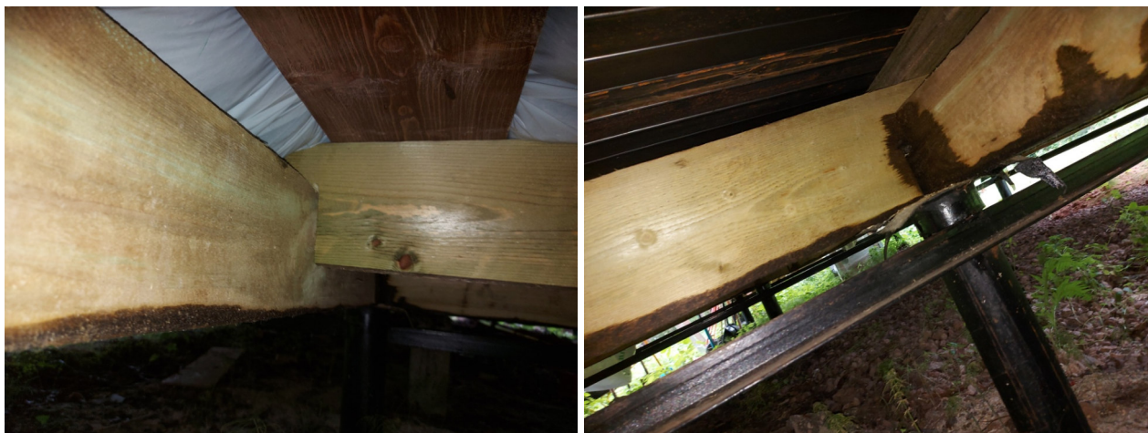
Фото №№ 78, 79 Подрезка балок более четверти высоты поперечного сечения элементов.
