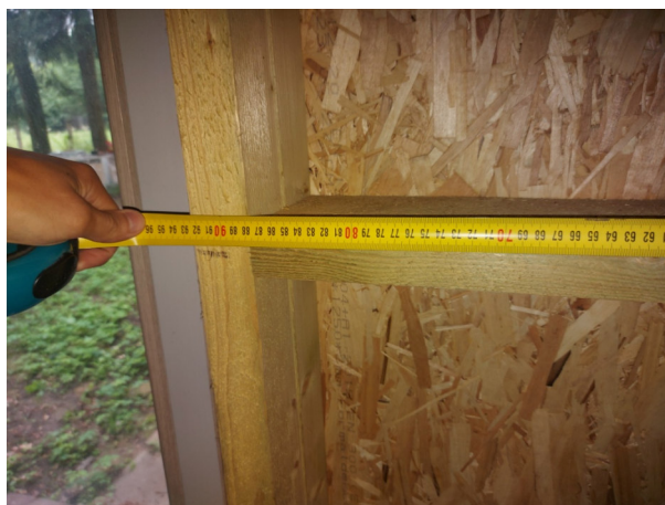
Фото № 55 Расстояние между стойками 875 мм.
