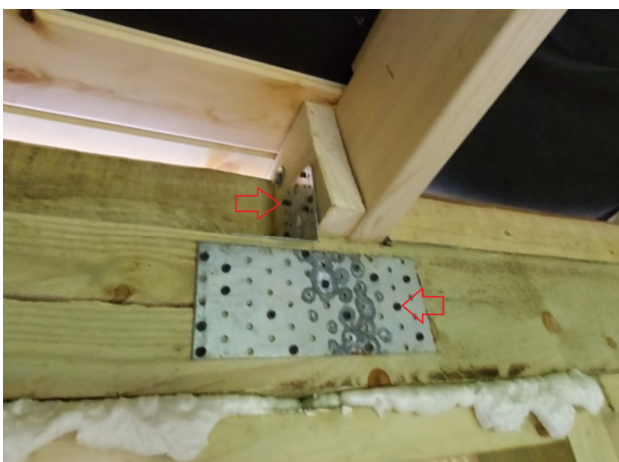
Фото №№ 9, 10 Крепление на фосфатированные («черные») саморезы.
