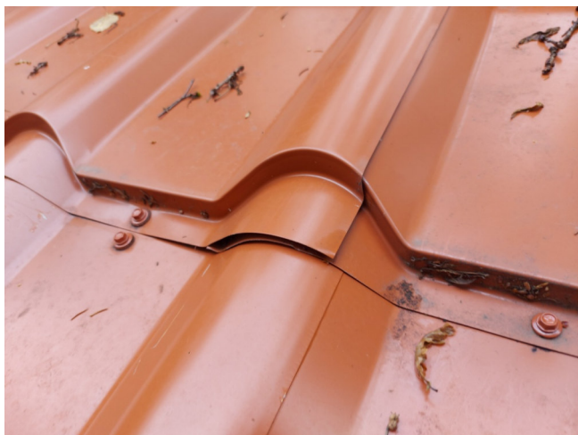
Фото № 174 Продольный стык не закреплен. Нарушен шаг расположения.
