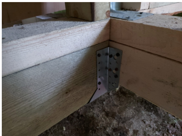
Фото №№ 13, 14 Крепление на фосфатированные («черные») саморезы.
