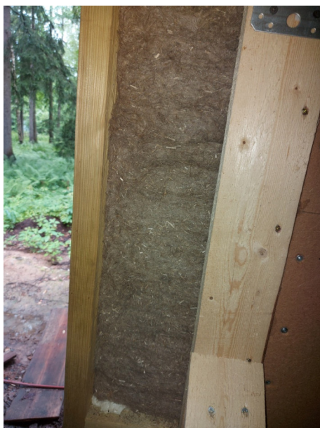
Фото №№ 33, 34 Утеплитель замят. Толщина слоя утепления 120 мм. Пароизоляционный слой отсутствует.
