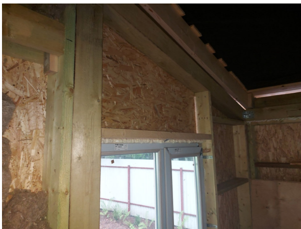
Фото №№ 47, 48 Устройство перемычек не выполнено.
