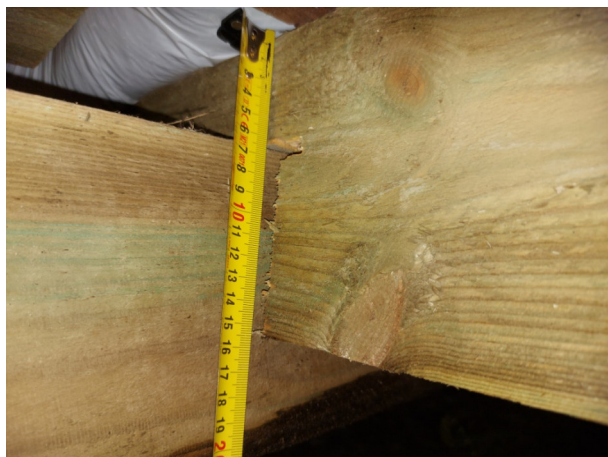
Фото №№ 86, 87 Подрезка балок более четверти высоты поперечного сечения элементов. Высота поперечного сечения 150 мм, подрезка на 85 и 95 мм.
