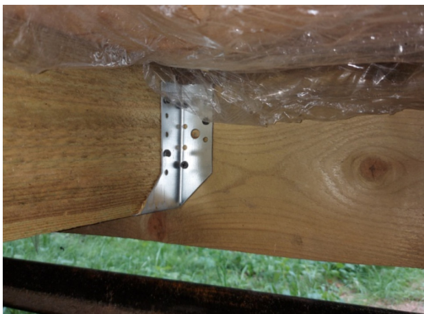
Фото №№ 19, 20 Крепление на фосфатированные («черные») саморезы.
