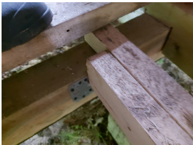
Фото №№ 84, 85 Подрезка балок более четверти высоты поперечного сечения элементов. Высота поперечного сечения 150 мм, подрезка на 100 мм.
