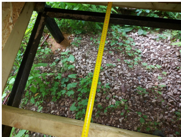
Фото №№ 66, 67 Расстояния между балками перекрытия 660 и 1 005 мм.
