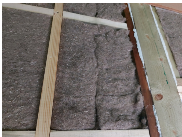
Фото №№ 42, 43 Утеплитель замят, уложен с зазорами. Пароизоляционный слой отсутствует.
