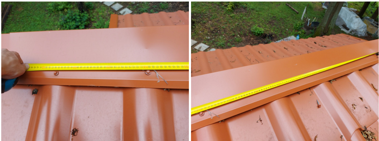
Фото №№ 141, 142 Шаг крепления саморезов 260 и 1100 мм.
