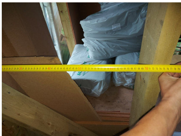
Фото №№ 60, 61 Расстояния между стойками 720 и 880 мм.
