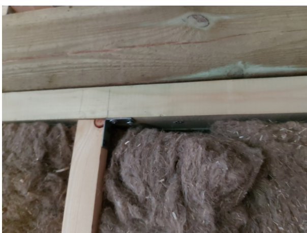
Фото №№ 37, 38 Утеплитель замят, уложен с зазорами. Пароизоляционный слой отсутствует.
