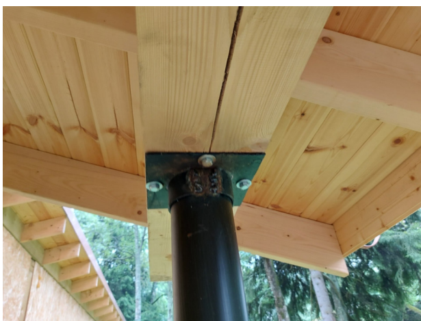
Фото №№ 108, 109 Отсутствует гидроизоляционный слой между металлом и древесиной.
