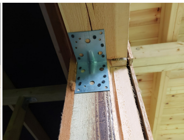
Фото №№ 21, 22 Крепление на фосфатированные («черные») саморезы.
