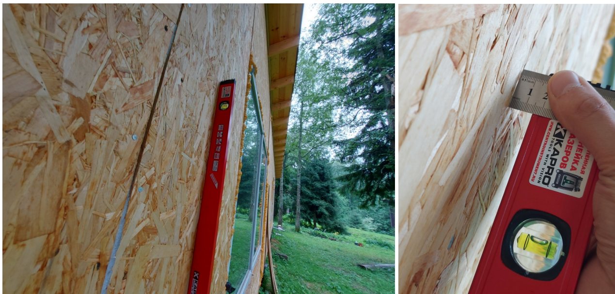
Фото №№ 122, 123 Отклонение от вертикали 15 мм.
