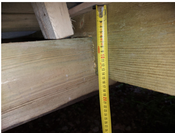
Фото №№ 86, 87 Подрезка балок более четверти высоты поперечного сечения элементов. Высота поперечного сечения 150 мм, подрезка на 85 и 95 мм.
