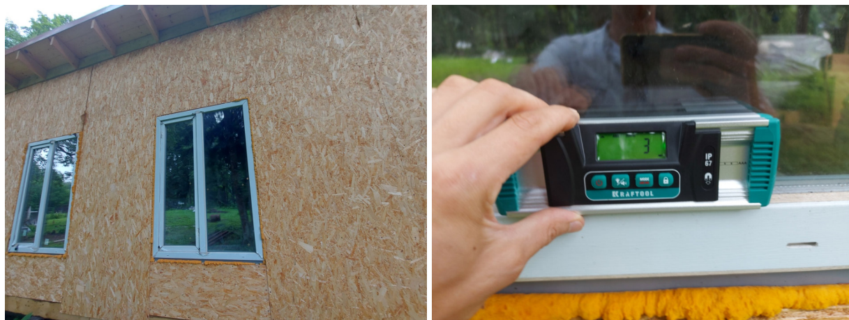
Фото №№ 114, 115 Общий вид оконного блока. Отклонение от горизонтали 3 мм на 1 м.
