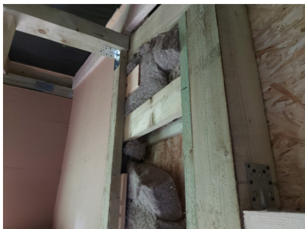
Фото №№ 44, 45 Утеплитель замят, уложен с зазорами. Пароизоляционный слой отсутствует.
