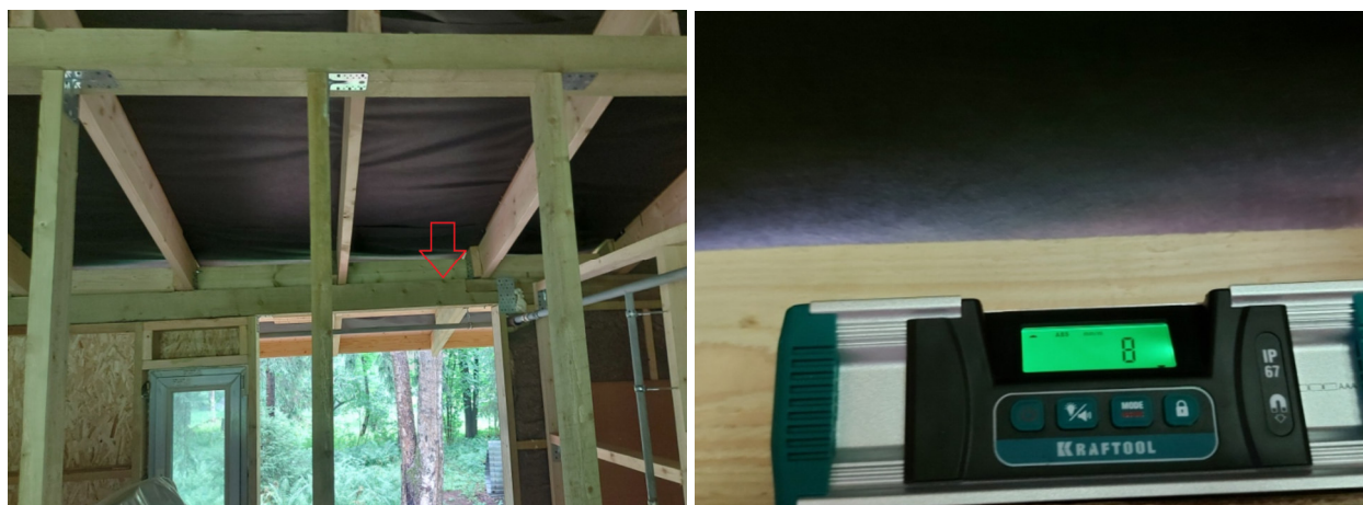
Фото №№ 95, 96 Отклонение от горизонтали 8 мм, на 1 м.
