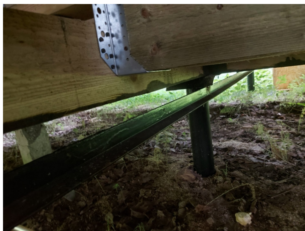
Фото №№ 15, 16 Крепление на фосфатированные («черные») саморезы.
