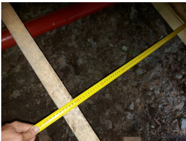
Фото №№ 62, 63 Расстояние между балками перекрытия 810 мм.
