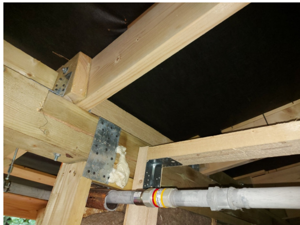
Фото №№ 11, 12 Крепление на фосфатированные («черные») саморезы.
