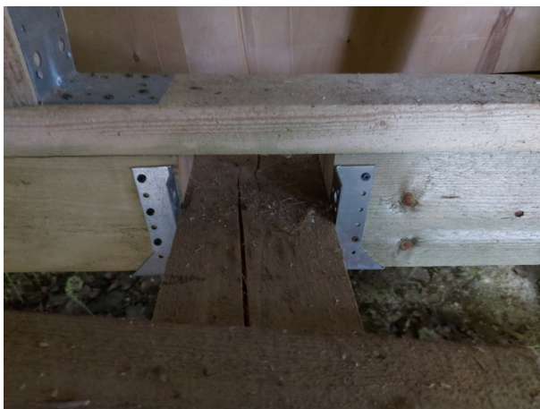
Фото №№ 13, 14 Крепление на фосфатированные («черные») саморезы.
