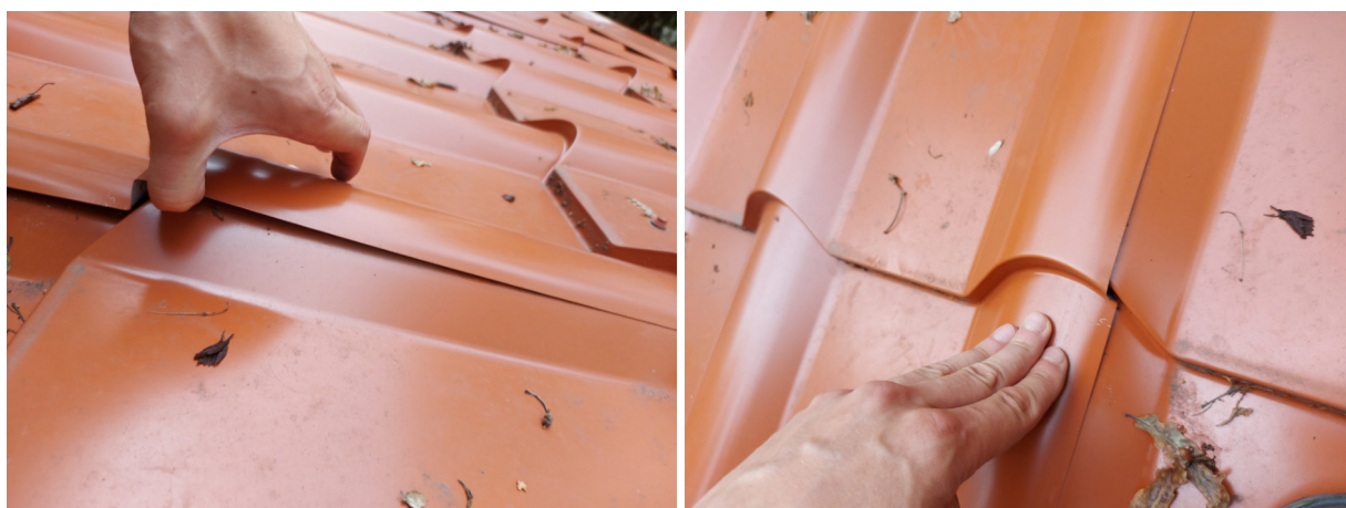
Фото №№ 172, 173 Продольные стыки металлочерепицы не закреплены.
