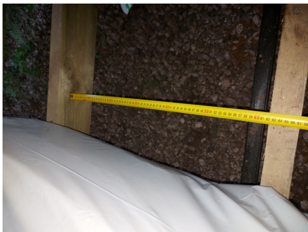
Фото № 68 Расстояние между балками перекрытия 620 мм.
