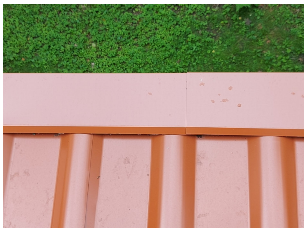
Фото №№ 137, 138 Торцевая планка закреплена некачественно.
