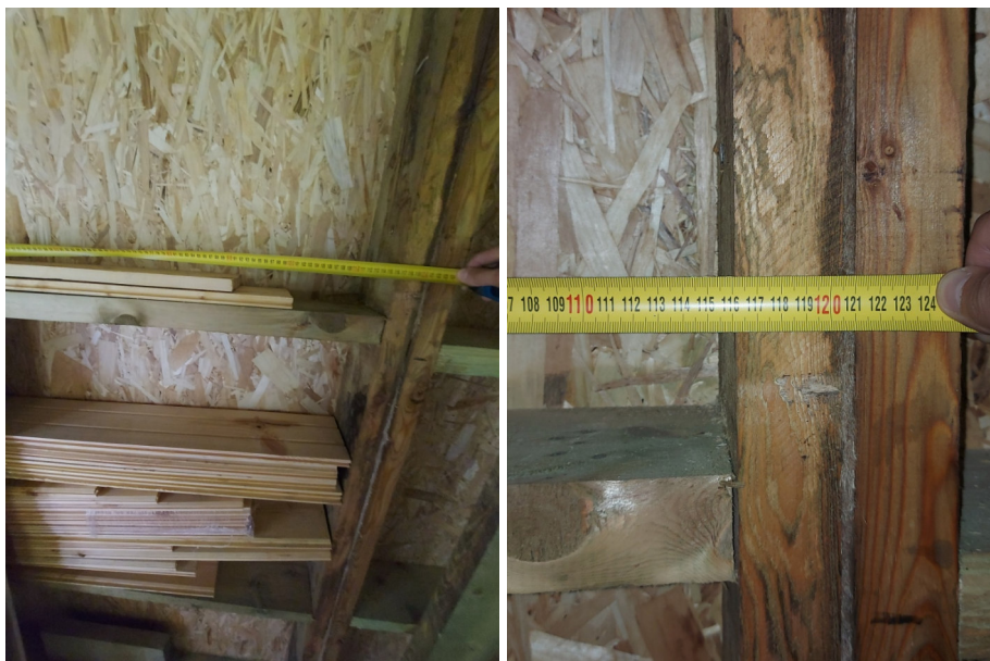
Фото №№ 53, 54 Расстояние между стойками 1 160 мм.
