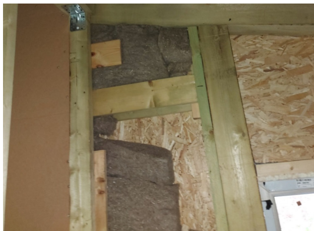
Фото №№ 31, 32 Утепление из кусков. Плиты утеплителя замяты, уложены с зазорами. Пароизоляционный слой отсутствует.
