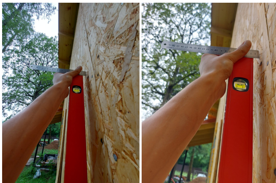
Фото №№ 124, 125 Отклонения от вертикали 15 мм.
