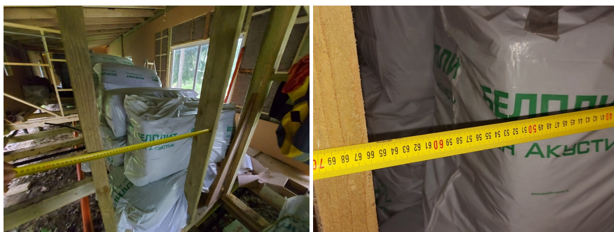
Фото №№ 56, 57 Расстояние между стойками 660 мм.
