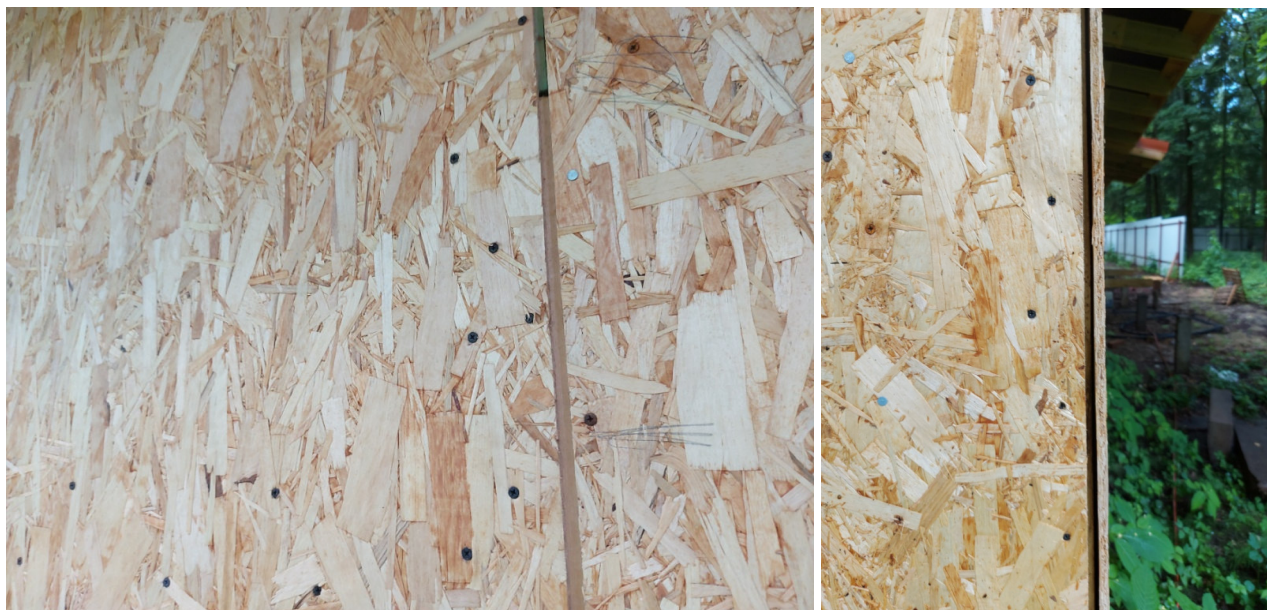
Фото №№ 119, 120 Крепление ОСП на фосфатированные (черные) саморезы.
