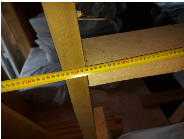
Фото №№ 58, 59 Расстояния между стойками 740 и 880 мм.
