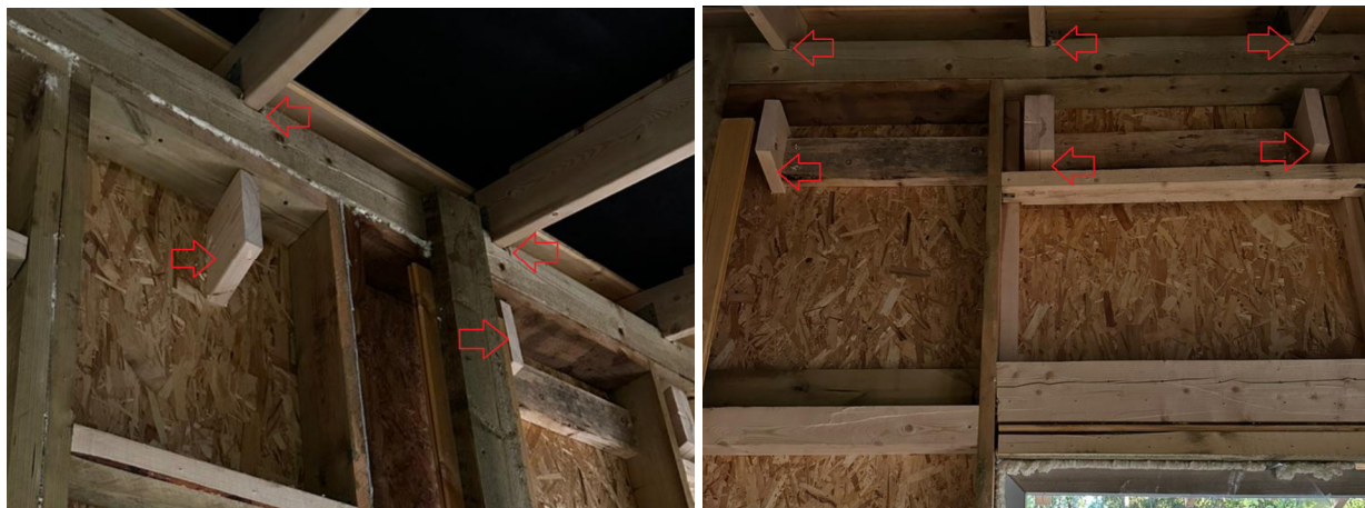
Фото №№ 28, 29 Стропила опираются на обшивку из ОСП, не имеют опоры на силовом каркасе. Врезки для стропил.
