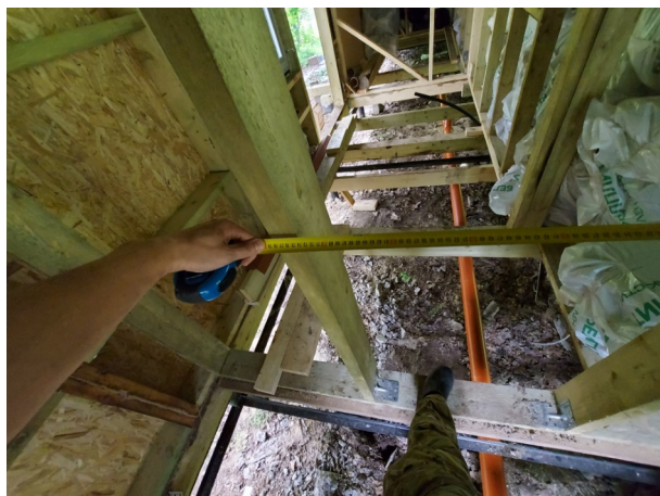
Фото №№ 58, 59 Расстояния между стойками 740 и 880 мм.
