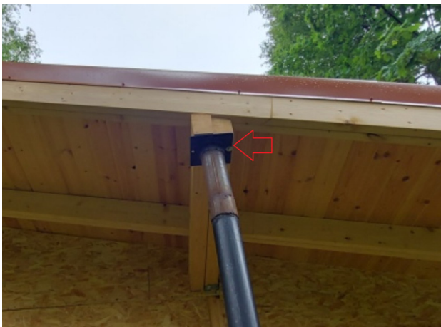
Фото №№ 104, 105 Отсутствует гидроизоляционный слой между металлом и древесиной.
