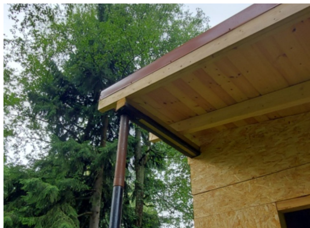
Фото №№ 104, 105 Отсутствует гидроизоляционный слой между металлом и древесиной.
