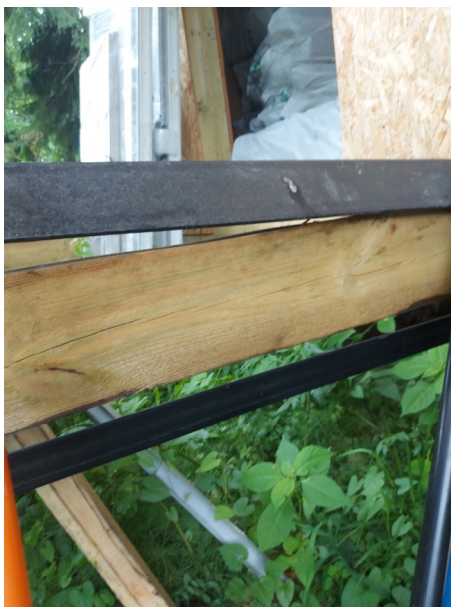
Фото №№ 100, 101 Угол обвязки не имеет опоры.
