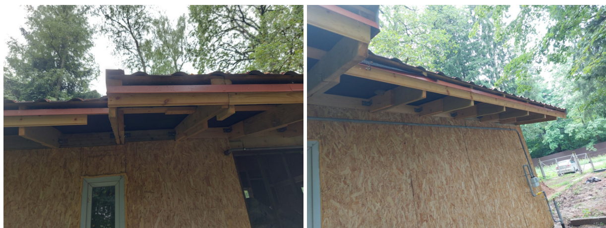
Фото №№ 133, 134 Отсутствует карнизная планка.
