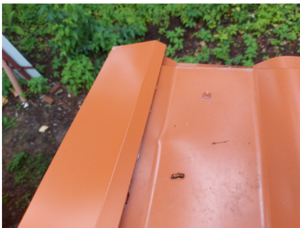
Фото №№ 161, 162 Повреждения элементов кровельного покрытия. Верх торцевой планки закреплен только на один саморез.
