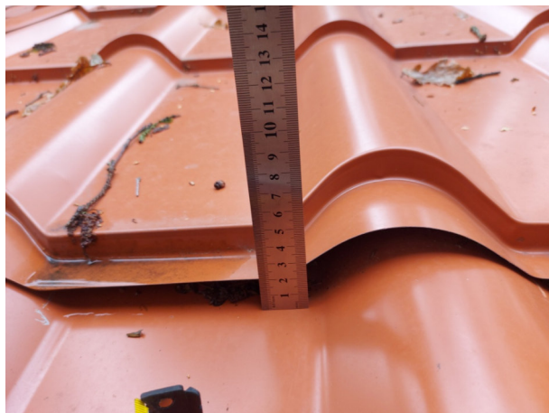
Фото №№ 147, 148 Смещения профилей листов. Зазоры до 25 мм.
