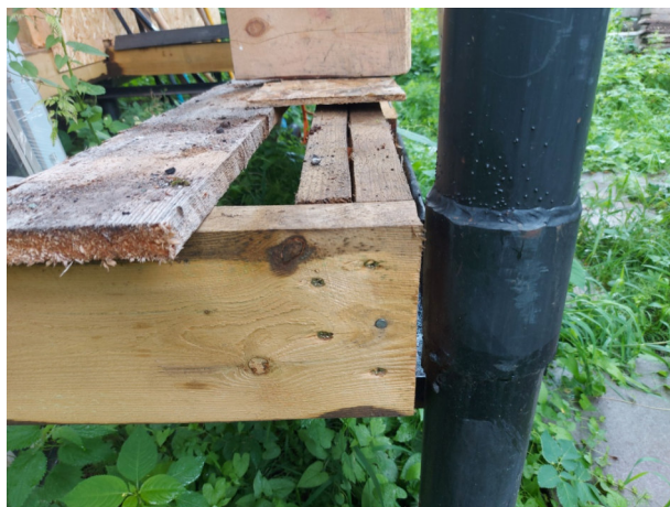
Фото №№ 98, 99 Угол обвязки не имеет опоры.
