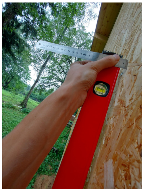
Фото № 130 Отклонение от вертикали 15 мм.
