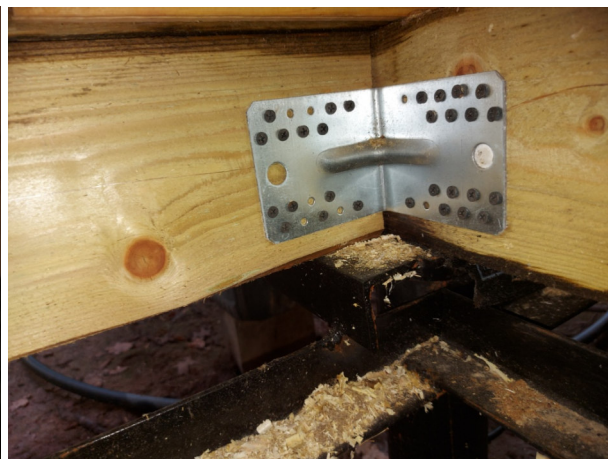
Фото №№ 17, 18 Крепление на фосфатированные («черные») саморезы.
