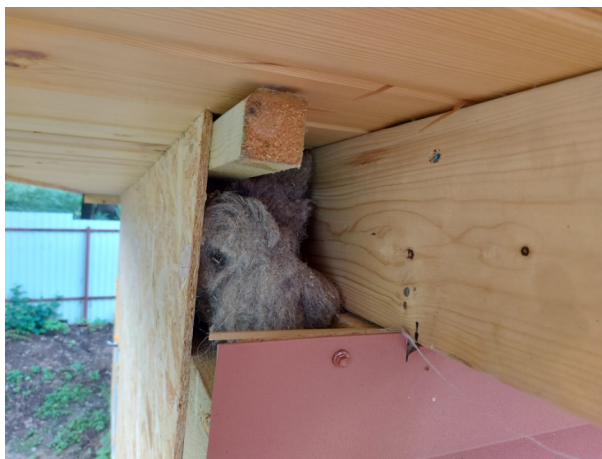
Фото №№ 178, 179 Узел примыкания фронтона к крыше выполнен с нарушением.
