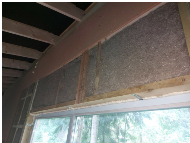
Фото №№ 47, 48 Устройство перемычек не выполнено.
