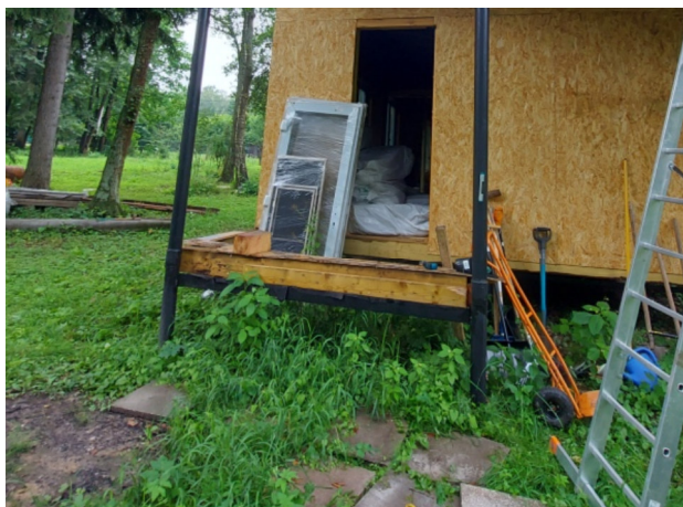
Фото № 97 Общий вид обвязки крыльца.
