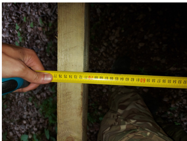
Фото №№ 64, 65 Расстояние между балками перекрытия 710 мм.
