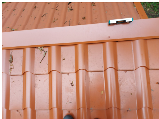
Фото №№ 176, 177 Отклонение карниза от горизонтали 19 мм, на 1 м.
