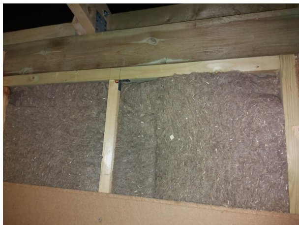
Фото №№ 35, 36 Утеплитель замят, уложен с зазорами. Пароизоляционный слой отсутствует.
