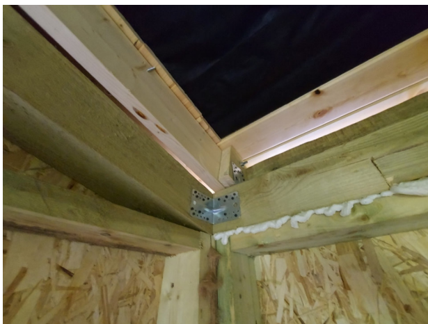
Фото №№ 7, 8 Крепление на фосфатированные («черные») саморезы.
