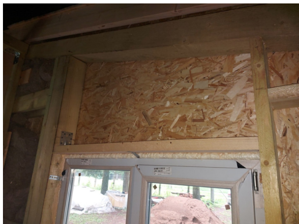
Фото №№ 49, 50 Устройство перемычек не выполнено.
