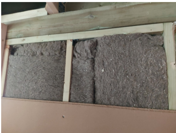
Фото №№ 35, 36 Утеплитель замят, уложен с зазорами. Пароизоляционный слой отсутствует.
