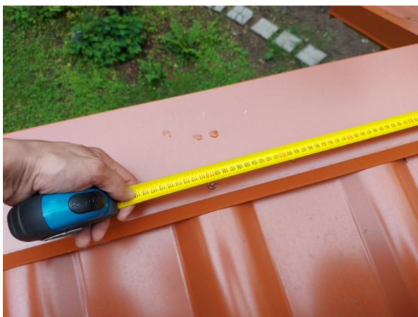
Фото №№ 139, 140 Шаг крепления саморезов 1100 мм.
