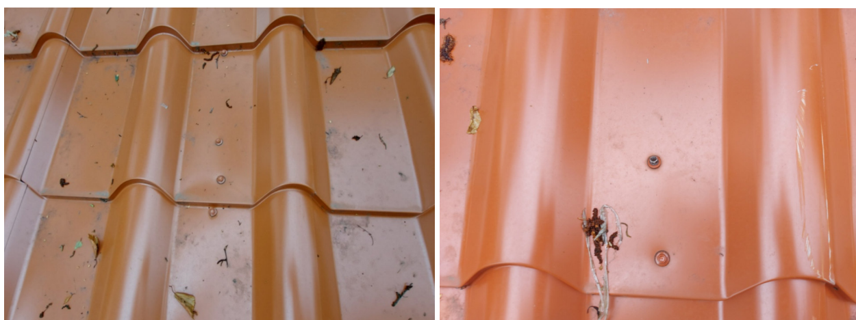
Фото №№ 166, 167 Нарушен шаг крепления и расположение саморезов.
