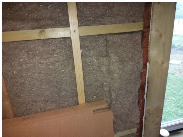
Фото №№ 40, 41 Утеплитель замят, уложен с зазорами. Пароизоляционный слой отсутствует.
