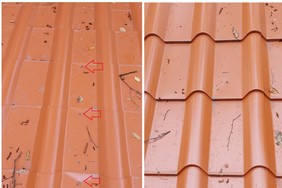
Фото №№ 168, 169 Нарушен шаг крепления и расположение саморезов.
