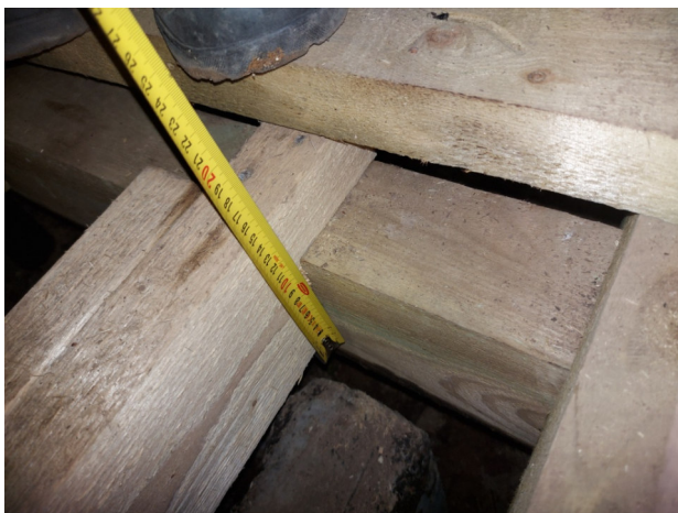
Фото №№ 84, 85 Подрезка балок более четверти высоты поперечного сечения элементов. Высота поперечного сечения 150 мм, подрезка на 100 мм.
