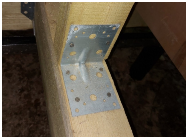
Фото №№ 17, 18 Крепление на фосфатированные («черные») саморезы.
