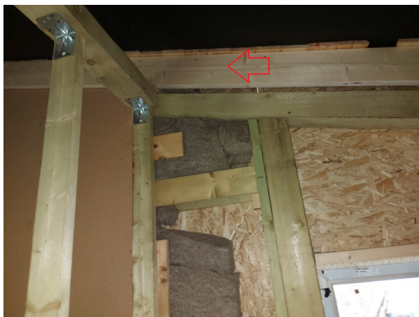
Фото № 180 Крайняя стропильная нога уложена со смещением вовнутрь.
