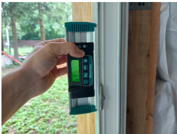
Фото № 116 Отклонение дверного блока из ПВХ профиля 3 мм, на 1 м.
