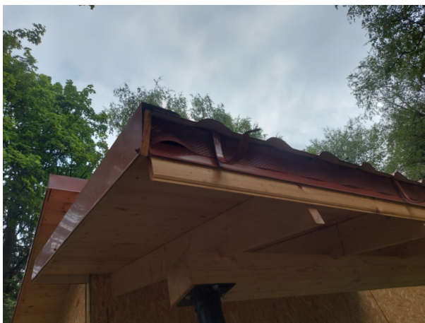
Фото №№ 135, 136 Отсутствует карнизная планка.
