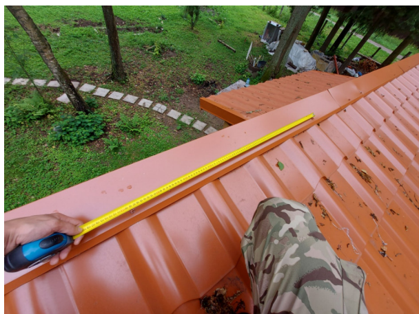
Фото №№ 139, 140 Шаг крепления саморезов 1100 мм.
