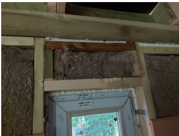
Фото №№ 49, 50 Устройство перемычек не выполнено.
