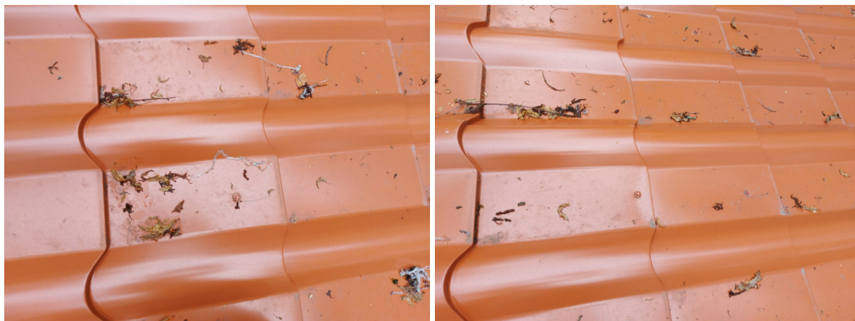
Фото №№ 170, 171 Нарушен шаг крепления и расположение саморезов.
