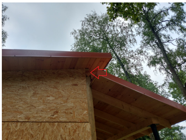
Фото №№ 178, 179 Узел примыкания фронтона к крыше выполнен с нарушением.
