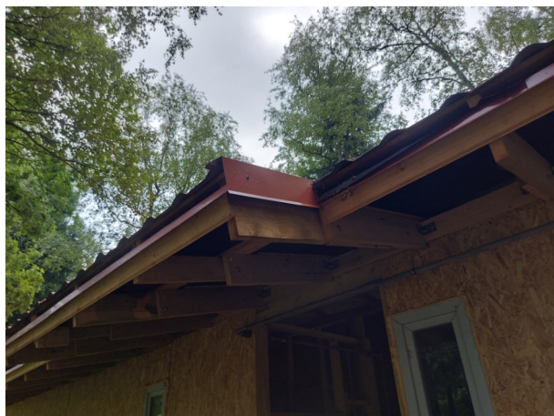
Фото №№ 135, 136 Отсутствует карнизная планка.
