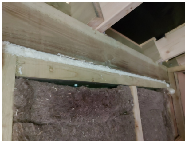
Фото № 39 Утеплитель замят, уложен с зазорами. Пароизоляционный слой отсутствует.
