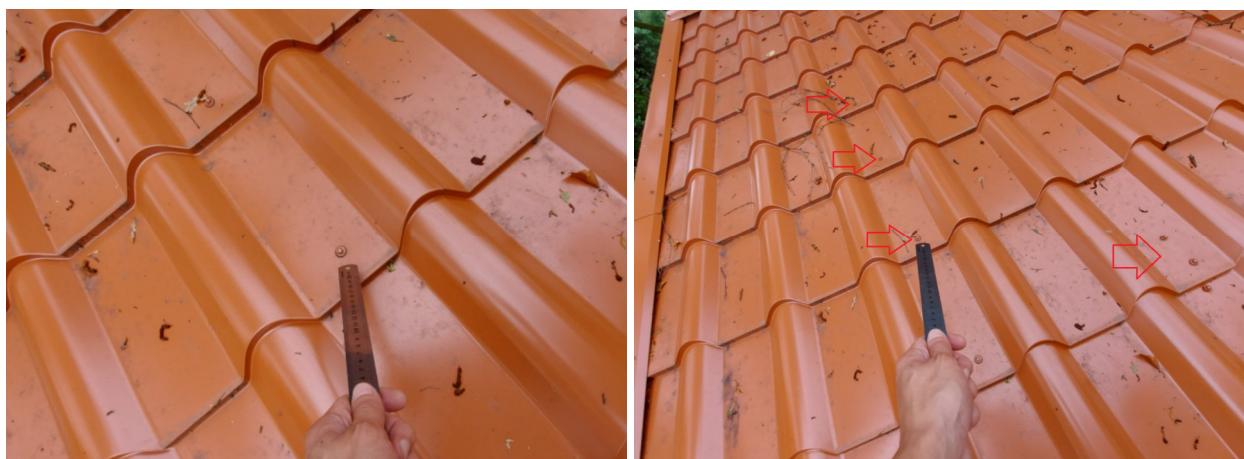
Фото №№ 164, 165 Нарушен шаг крепления и расположение саморезов.
