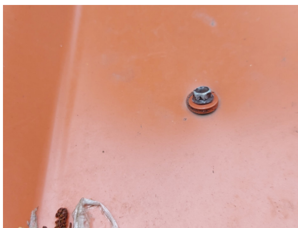
Фото № 175 Саморез закручен с нарушением.
