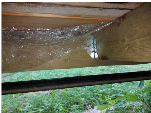
Фото №№ 19, 20 Крепление на фосфатированные («черные») саморезы.
