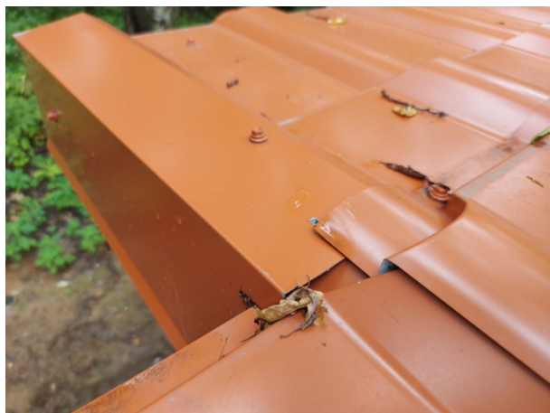
Фото №№ 161, 162 Повреждения элементов кровельного покрытия. Верх торцевой планки закреплен только на один саморез.
