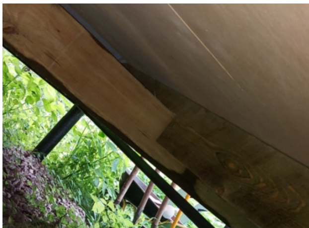
Фото №№ 80, 81 Подрезка балок более четверти высоты поперечного сечения элементов.
